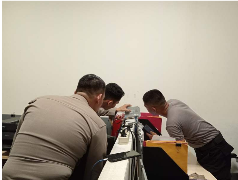
Gambar 3. 1 Perbaikan Jaringan di SAMAPTA Polda Riau
