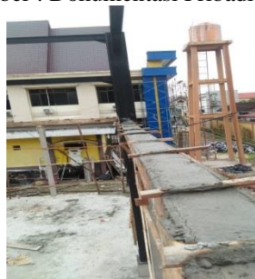
Gambar 3.26 Pengecoran Balok Latei (Sumber : Dokumentasi Pribadi, 2023)
