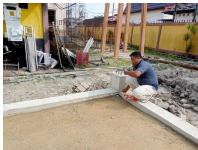
Gambar 3.29 Pengukuran Jarak Kolom Pedestal (Sumber : Dokumentasi Pribadi, 2023)
