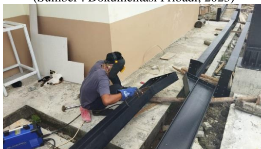
Gambar 3.12 Pengelasan Stiffener pada Besi WF (Sumber : Dokumentasi Pribadi, 2023)
