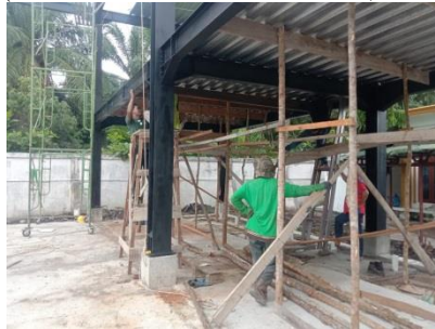
Gambar 3.16 Pemasangan Floordeck (Sumber : Dokumentasi Pribadi, 2023)
