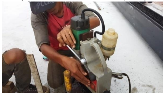
Gambar 3.11 Pelubangan pada Plat Penyambung (Sumber : Dokumentasi Pribadi, 2023)
