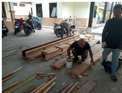
Gambar 3.21 Pembuatan Bekisting Kolom Praktis (Sumber : Dokumentasi Pribadi, 2023)
