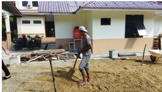
Gambar 3.1 Pengurugan Tanah (Sumber : Dokumentasi Pribadi, 2023)
