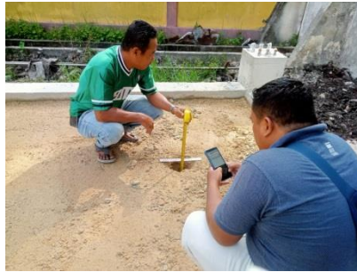
Gambar 3.30 Pengukuran Tebal Tanah Urugan (Sumber : Dokumentasi Pribadi, 2023)
