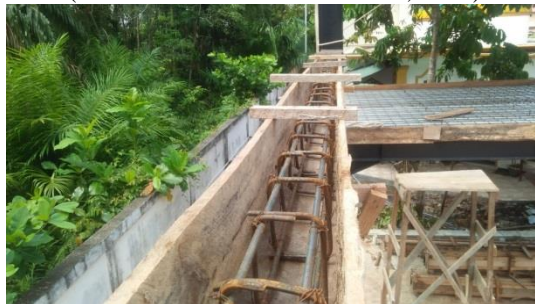
Gambar 3.25 Bekisting dan Penulangan Balok Latei (Sumber : Dokumentasi Pribadi, 2023)
