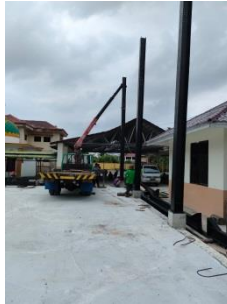
Gambar 3.9 Pemasangan Kolom H Beam menggunakan Mobile Crane (Sumber : Dokumentasi Pribadi, 2023)
