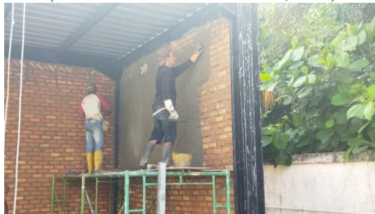
Gambar 3.28 Plasteran Dinding Bata (Sumber : Dokumentasi Pribadi, 2023)
