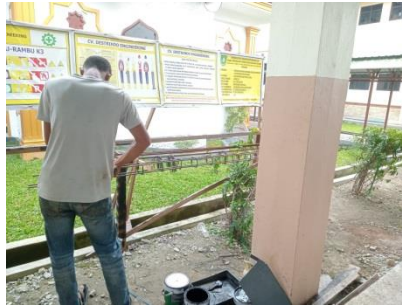
Gambar 3.22 Pembuatan Tulangan Kolom Praktis (Sumber : Dokumentasi Pribadi, 2023)
