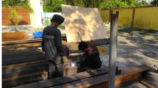
Gambar 3.4 Pengelasan Pada H Beam (Sumber : Dokumentasi Pribadi, 2023)
