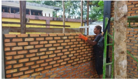
Gambar 3.27 Pemasangan Dinding Bata (Sumber : Dokumentasi Pribadi, 2023)
