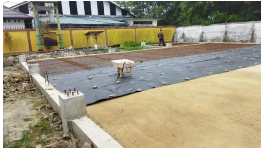
Gambar 3.15 Hampanan Plastik Hitam, Beton Decking dan Penulangan Wiremesh Lantai Dasar (Sumber : Dokumentasi Pribadi, 2023)
