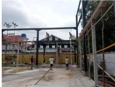
Gambar 3.17 Pemasangan Tulangan Wiremesh pada Tingkat 2 (Sumber : Dokumentasi Pribadi, 2023)
