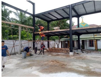
Gambar 3.19 Pengecoran Plat Lantai Tribun (Sumber : Dokumentasi Pribadi, 2023)
