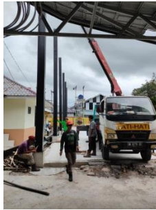
Gambar 3.8 Mobile Crane (Sumber : Dokumentasi Pribadi, 2023)
