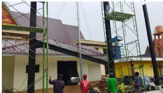
Gambar 3.14 Pemasangan Balok Besi WF (Sumber : Dokumentasi Pribadi, 2023)
