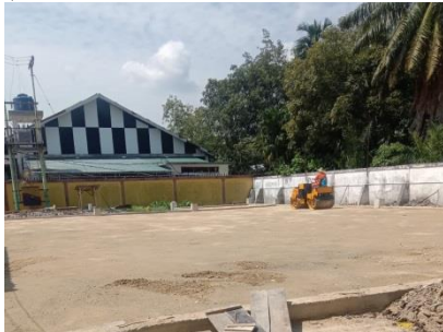
Gambar 3.3 Pematatan Menggunakan Baby Roller (Sumber : Dokumentasi Pribadi, 2023)
