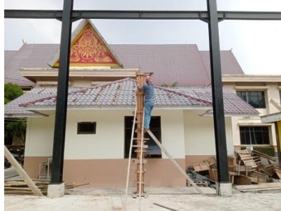
Gambar 3.23 Pengecoran Kolom Praktis (Sumber : Dokumentasi Pribadi, 2023)
