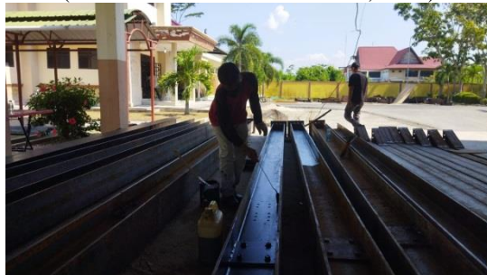
Gambar 3.6 Pengecatan H Beam yang Sudah Selesai Fabrikasi (Sumber : Dokumentasi Pribadi, 2023)
