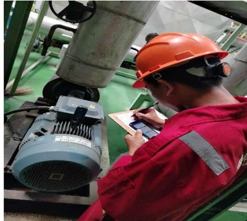
Pengecekan Vibrasi pada pompa sentrifugal
