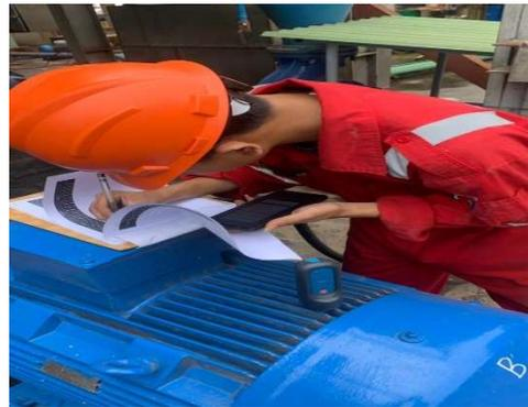
Pengecekan Vibrasi pada pompa *cooling tower*
