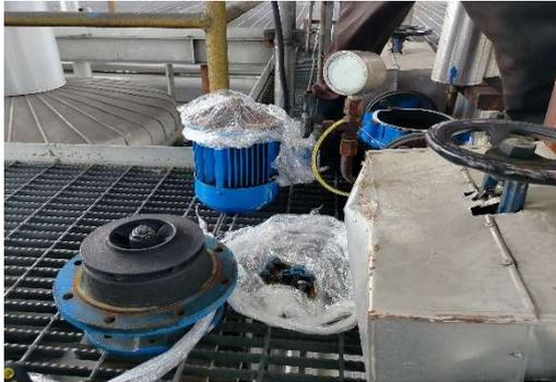
Memasang *Impeller* pada Pompa *Booster*
