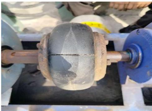
Pengecekan *rubber* kopling pada pompa sentrifugal
