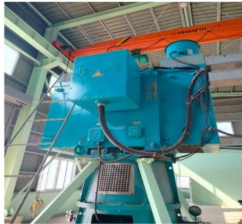
Pengecekan Vibrasi pada pompa SWI (sea water intake)
