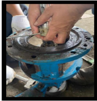
Gambar 4.13 Proses Pemasangan Mechanical Seal ( Sumber Dokumentasi Pribadi )
