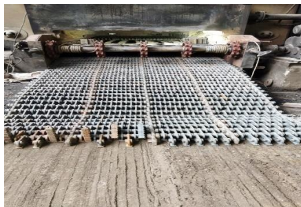
Gambar 4.6 Pemasangan Chainrate
