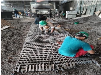
Gambar 4.5 Perbaikan Chainrate Sumber: Dokumentasi Pribadi
