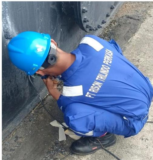
Gambar 2.2 pemasangan grounding
