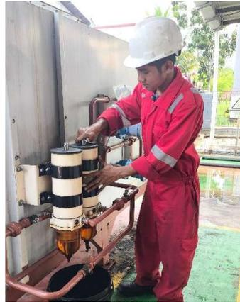
Gambar 4.15 Penggantian Filter Racor
