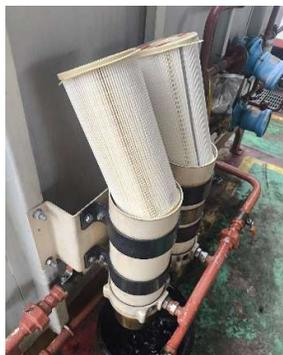
Gambar 4.22 Masukkan Filter Racor yang Baru
