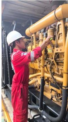
Gambar 4.14 Pemeliharaan Mesin Caterpillar Type 3512B
