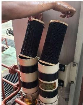
Gambar 4.19 Keluarkan Filter Racor yang Kotor
