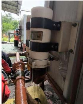
Gambar 4.18 Buka Baut Pembuangan Filter Racor
