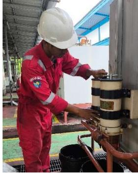
Gambar 4.17 Buka Penutup Filter Racor
