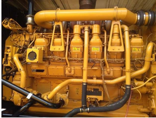
Gambar 4.6. Mesin Caterpillar type 3512B Sumber: PT. PLN (Persero) PLTD II Bengkalis
