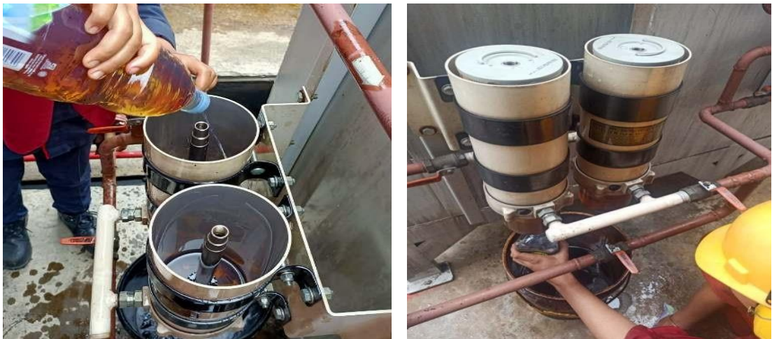
Gambar 4.6.4 bersihkan bagian dalam rumah filter menggunakan minyak solar bersih Sumber: PT. PLN (Persero) PLTD II Bengkalis
