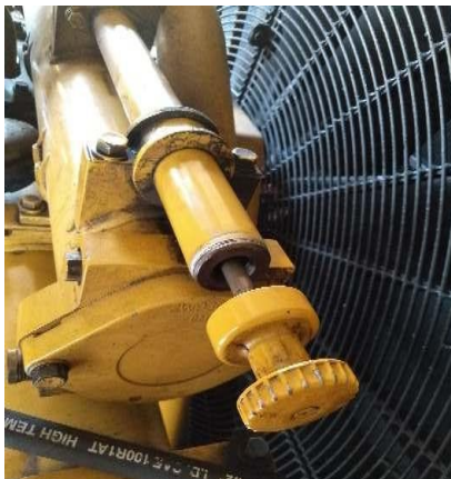
Gambar 4.6.4 memastikan kembali filter sudah terpasang dengan benar Sumber: PT. PLN (Persero) PLTD II Bengkalis
