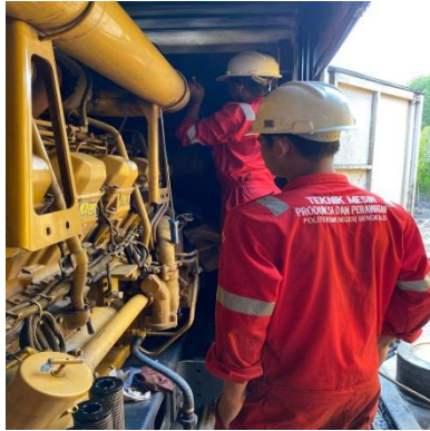
Gambar 4.6.3 keluarkan fuel filter yang sudah kotor sebanyak 5 buah Sumber: PT. PLN (Persero) PLTD II Bengkalis
