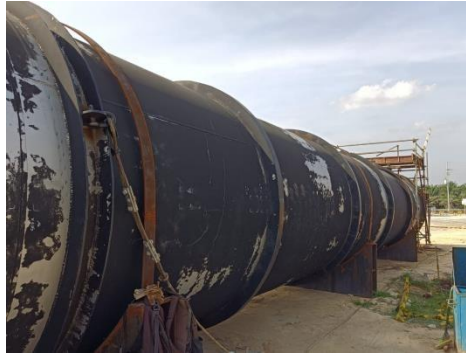
Gambar 4. 2 Sebelum pemasangan ( Sumber: PT Sumigita Jaya )
