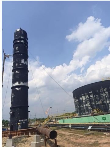
Gambar 4. 7 Pemasangan baut pondasi ( Sumber: PT Sumigita Jaya )
