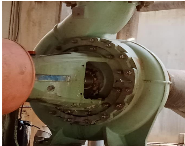
Gambar 4. 9 Pompa Sentrifugal
