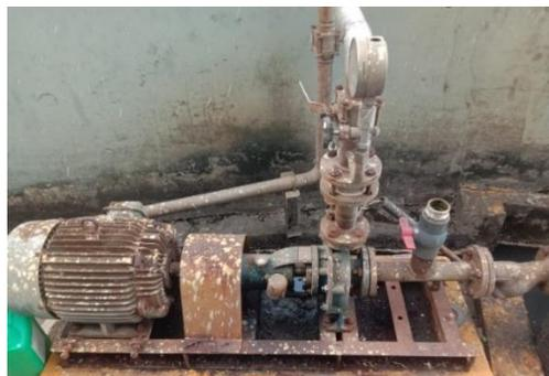
Gambar 4. 1 Pompa sntrifugal pembuangan air limbah.sumber Dokumentasi penulis
