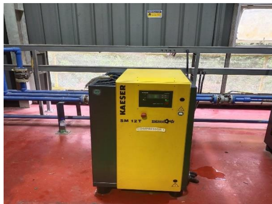
Gambar 4.2 Mesin Kompresor KAESER SM 12T
