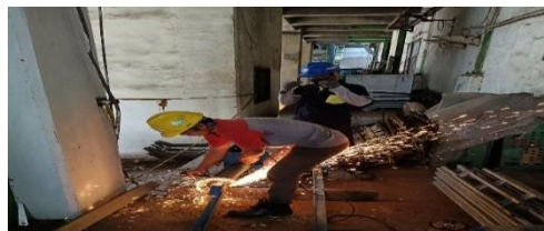
Gambar 2. 6 Melakukan pemotongan besi
