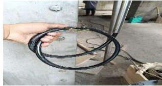
Gambar 2. 21 masukan kabel ke dalam pipa konduid
