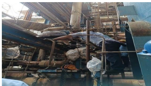
Gambar 2. 10 Memasang gasket pada meyambungan pipa
