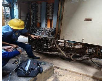
Gambar 2. 4 Mengganti Kabel armour di panel JA
