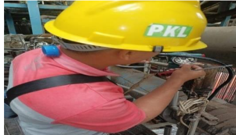
Gambar 2. 16 Memasukan kabel kedalam pipa konduid
