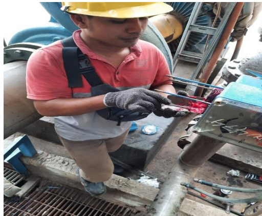
Gambar 2. 24 Membersihkan dalam cylinder dan pasang grease
