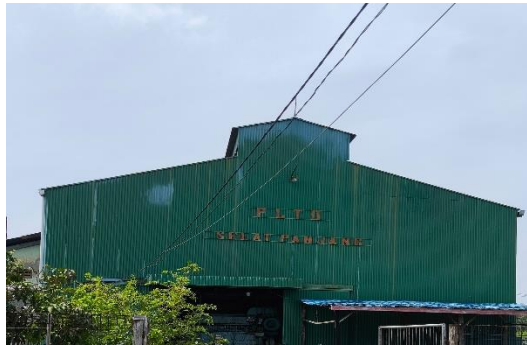
Sumber: PT. PLN (Persero) Selatpanjang
