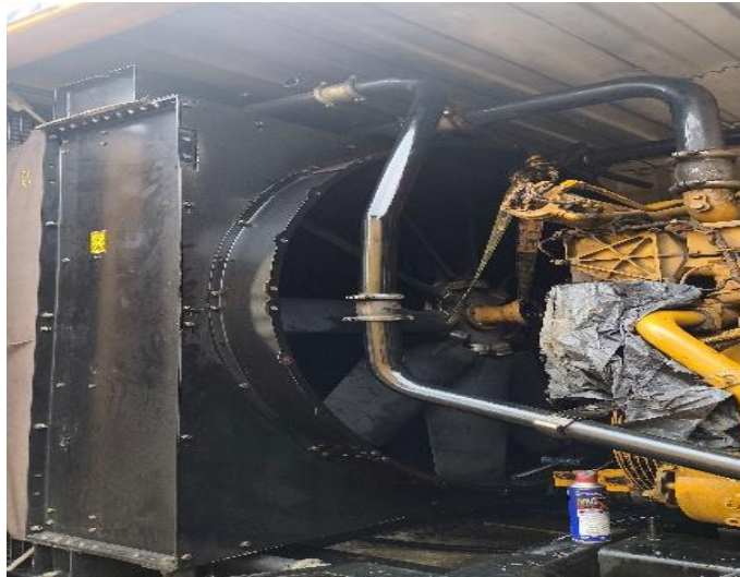
Gambar 4.8 aliran dari termostat bagian bawah menuju ke radiator
