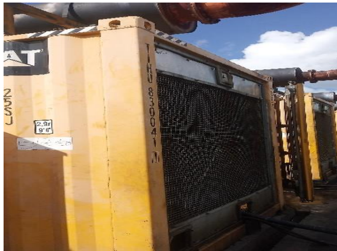
Gambar 4.9 radiator mesin caterpillar type 3512 B bagian depan
