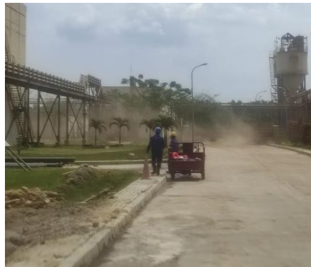
Gambar 4. 12 lingkungan cooling tower Sumber: Dokumentasi pribadi
