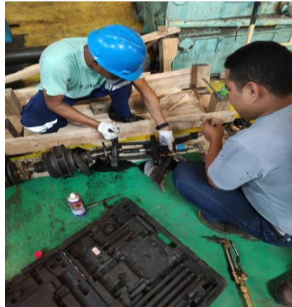
Gambar 3. 5 Pembongkaran pompa C3WP Sumber: dokumentasi pribadi
