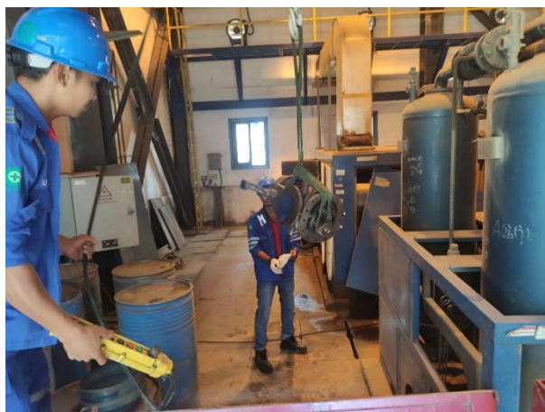
Gambar 3. 6 Pembongkaran pada Air Compressor Sumber: dokumentasi pribadi
