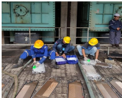
Gambar 3. 2 Cleaning PHE Sumber: dokumentasi pribadi
