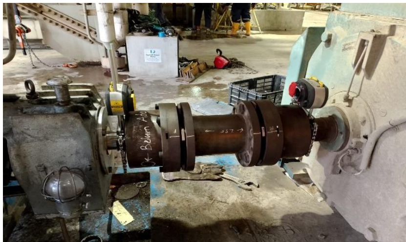
Gambar 4. 1 Gambar proses and Aligment pada boiler
