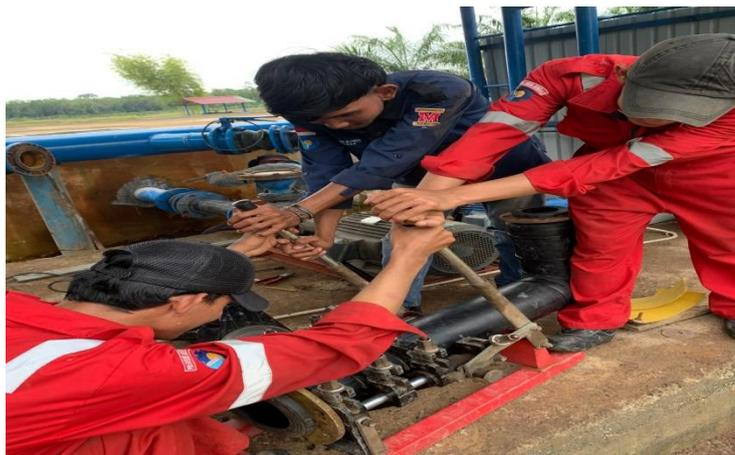
Gambar 3. 3 Penyambungan Pipa PE
