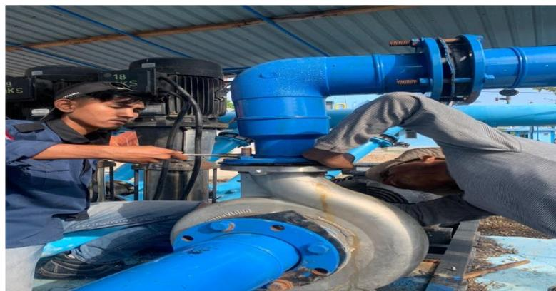
Gambar 3. 1 PM Elbow Pipa Terhubung Ke Pompa
