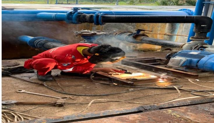
Gambar 3. 4 Pengelasan Dudukan Dinamo Pompa
