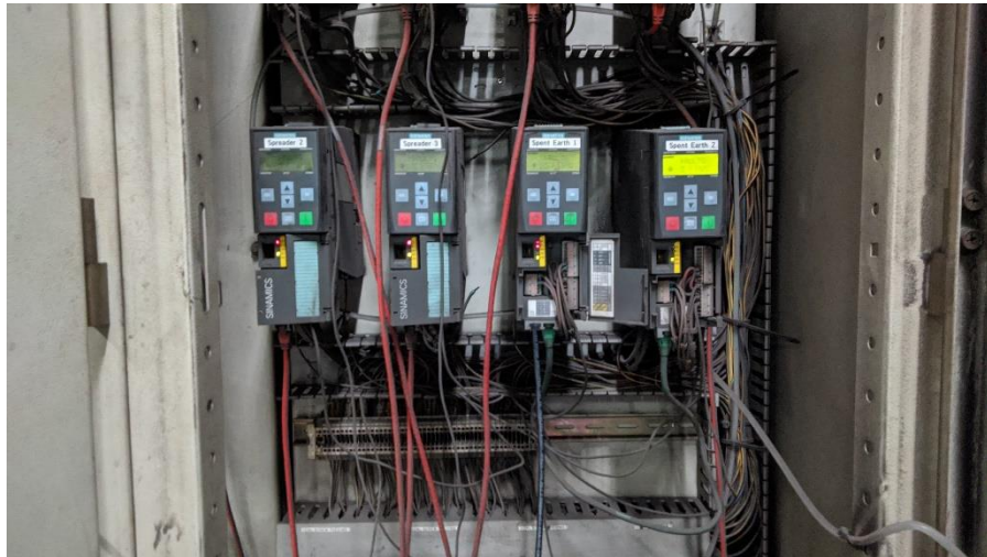
Gambar 2. 32 Pergantian Kabel LAN Inverter di Plan LPB (Sumber: Dokumentasi, 2024)
