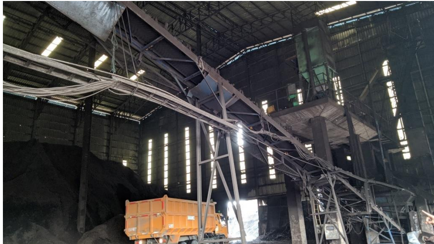
Gambar 2. 27 Penarikan kabel dan membuatudukan kabel pada plan HPB (Sumber: Dokumentasi, 2024)
