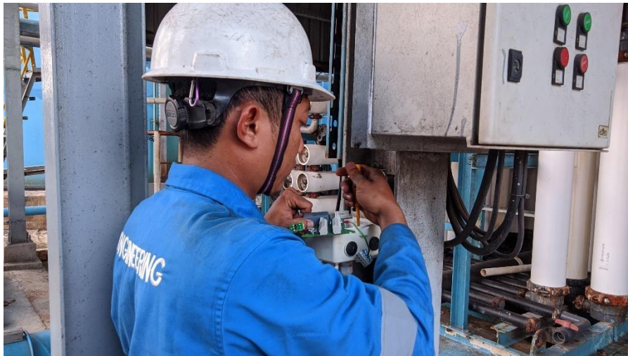
Gambar 2. 22 Install flow meter dan penarikan kabel sensor line PDAM di plan WTP (Sumber: Dokumentasi, 2024)
