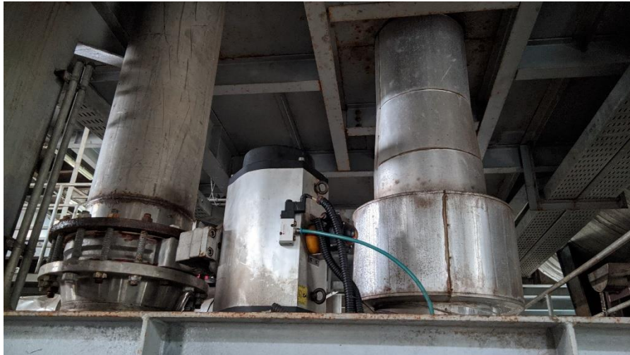
Gambar 2. 20 Perbaikan selonoid V7325A di plan refinery 1 (Sumber: Dokumentasi, 2024)
