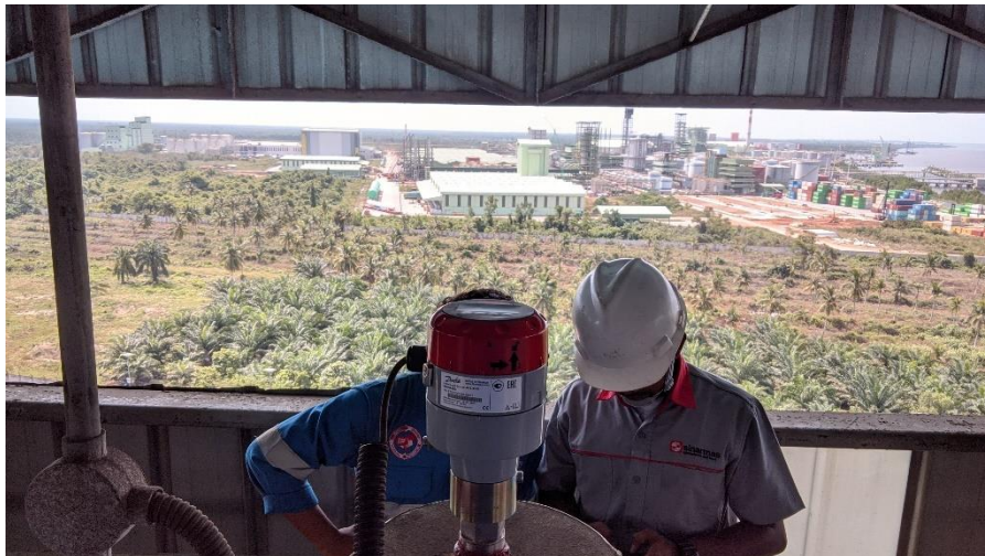
Gambar 2. 19 Perbaiki sensor level separator ice condensing di plan refinery 1 (Sumber: Dokumentasi, 2024)
