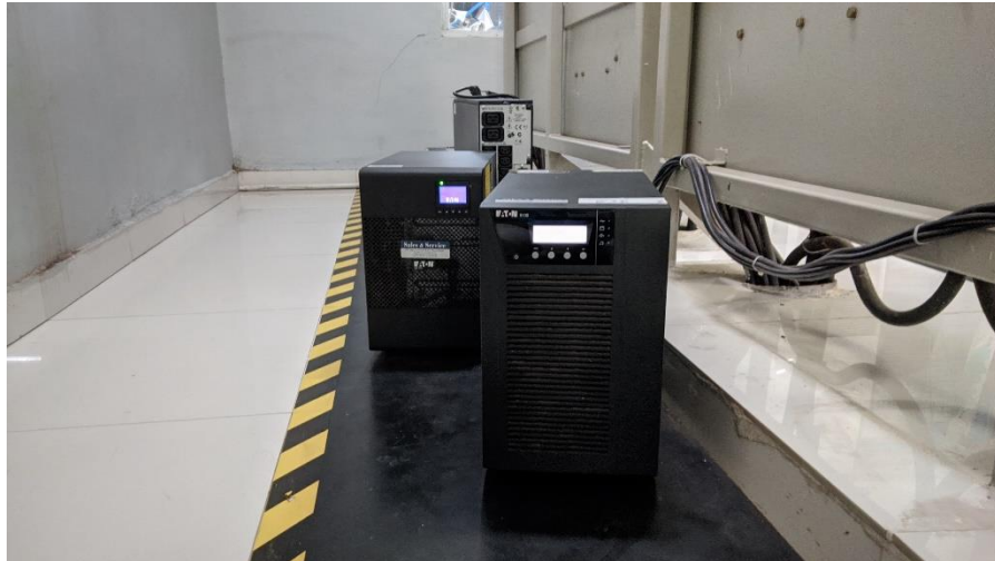
Gambar 2. 30 Perbaikan UPS di room Fraksinasi di Plan Refinery 2 . (Sumber: Dokumentasi, 2024)
