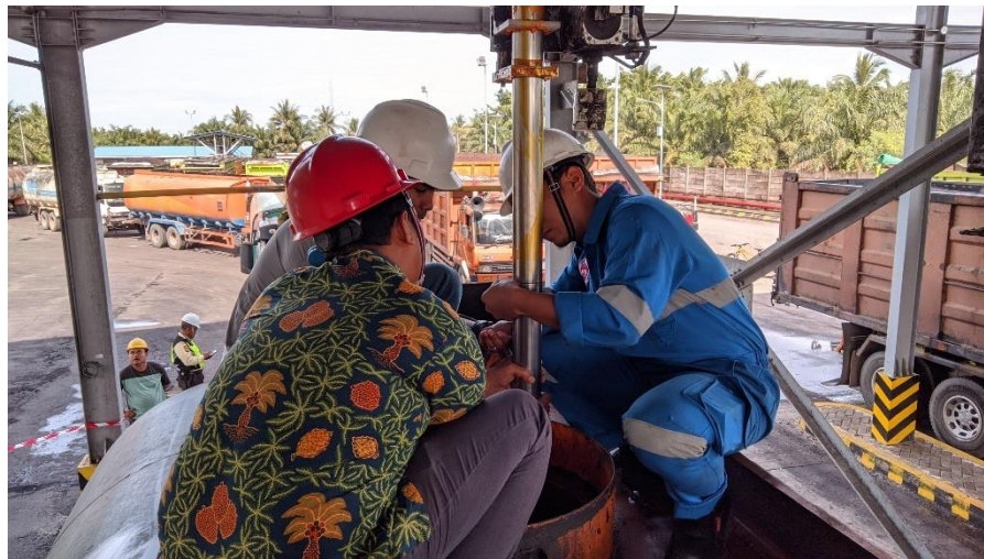
Gambar 2. 28 Perbaikan cylinder di CPO probe (Sumber: Dokumentasi, 2024)
