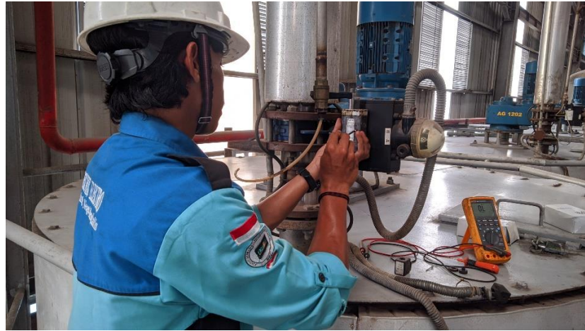
Gambar 2.34 Pergantian Solenoid pada Aktuator di Plan Refinery 2 . (Sumber: Dokumentasi, 2024)
