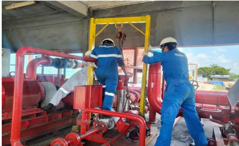
Gambar 2. 16 Instal motor pompa joki di fire pump (Sumber: Dokumentasi, 2024)
