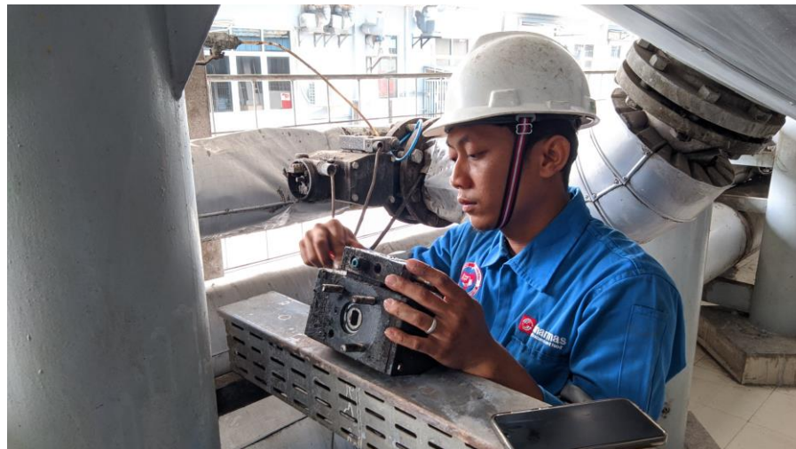
Gambar 2. 35 Perbaikan Solenoid pada Aktuator Plan Refinery 2 . (Sumber: Dokumentasi, 2024)
