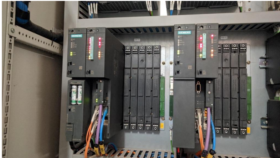
Gambar 2. 29 Pergantian Baterai pada PLC room Fraksinasi di Plan Refinery 2 . (Sumber: Dokumentasi, 2024)
