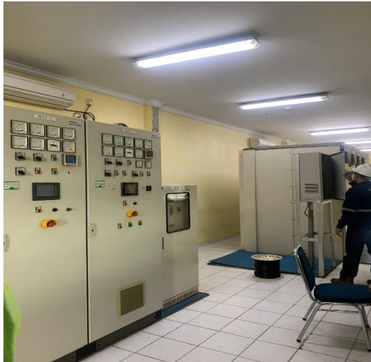
Gambar 2.5 Survey Lapangan Melihat Ruang SKL Sumber: (Dokumentasi, 2024)
