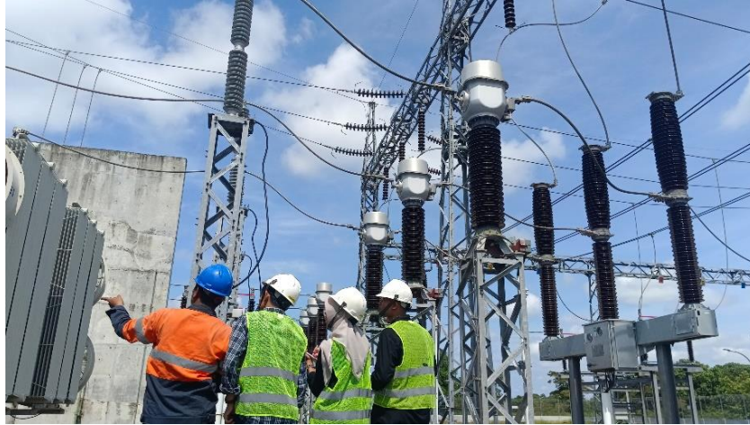
Gambar 2.2 Survey Lapangan Gardu Induk 150 KV Sumber: (Dokumentasi, 2024)
