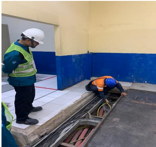
Gambar 2.6 Pemasangan Netral Grounding Trafo Sumber: (Dokumentasi, 2024)
