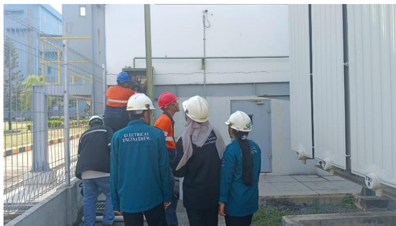
Gambar 2.4 Survey Lapangan Perawatan Transformer Protector Sumber: (Dokumentasi, 2024)
