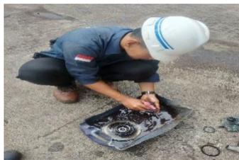
Gambar 4. 13 Pembersihan komponen pompa
