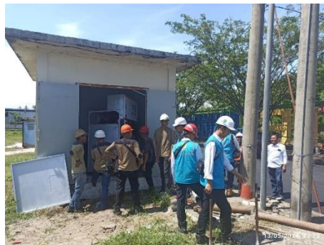
Gambar 2. 45 Pekerjaan Mengganti Kubikel Sumber: (Dokumentasi Pribadi, 2024)
