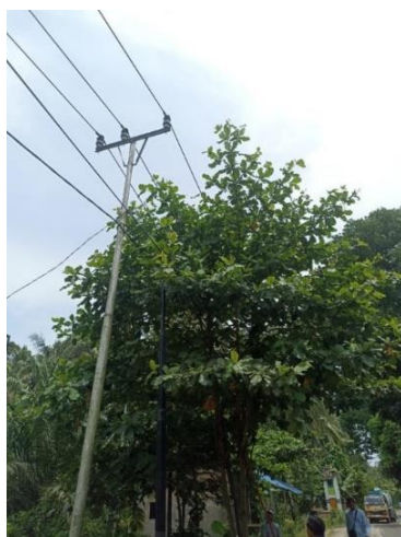
Gambar 2. 20 Kegiatan ROW ( Right of Way ) Sumber: (Dokumentasi Pribadi, 2024)
