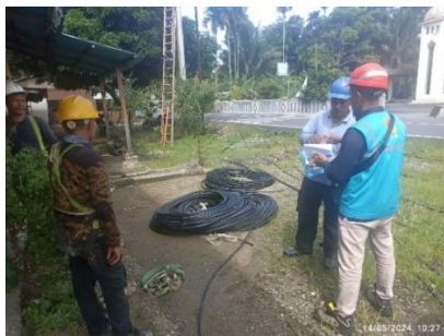
Gambar 2. 46 Pekerjaan mengganti kabel A3C menjadi A3CS Sumber: (Dokumentasi Pribadi, 2024)
