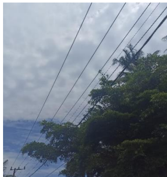
Gambar 2. 63 Kegiatan ROW ( Right of Way ) Sumber: (Dokumentasi Pribadi, 2024)
