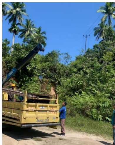
Gambar 2. 35 Inspeksi Pekerjaan Mengganti Kabel JTM Sumber: (Dokumentasi Pribadi, 2024)
