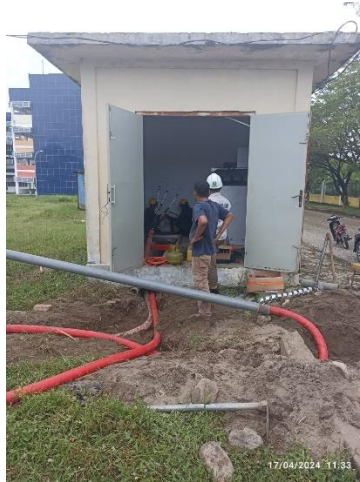
Gambar 2. 34 Inspeksi Mengganti Kabel Tanah POLTEKPEL SUMBAR Sumber: (Dokumentasi Pribadi, 2024)
