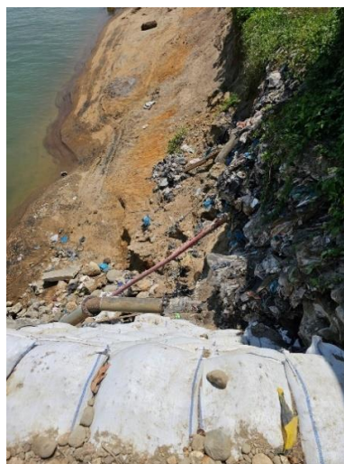
Gambar 2. 23 Pengecekan Kabel Tanah BIM Pasca Banjir Sumber: (Dokumentasi Pribadi, 2024)
