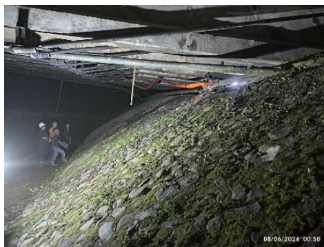
Gambar 2. 59 Jointing Kabel Bawah Tanah Sumber: (Dokumentasi Pribadi, 2024)
