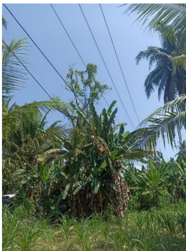
Gambar 2. 21 Kegiatan ROW ( Right of Way ) Sumber: (Dokumentasi Pribadi, 2024)
