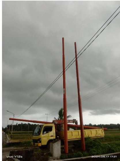
Gambar 2. 49 Pemasangan Tiang Baru Sumber: (Dokumentasi Pribadi, 2024)
