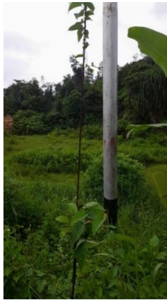
Gambar 2. 9 Kegiatan ROW ( Right of Way ) Sumber: (Dokumentasi pribadi, 2024)
