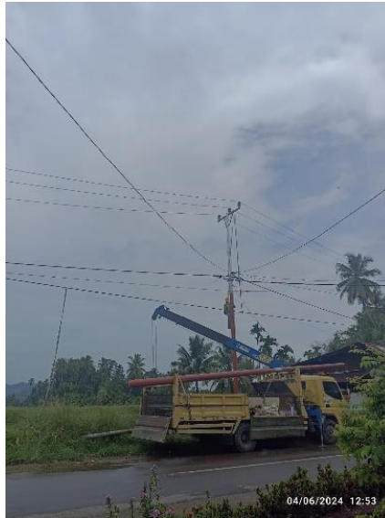
Gambar 2. 58 Perbaikan Tiang Listrik Tegangan Menengah Sumber: (Dokumentasi Pribadi, 2024)
