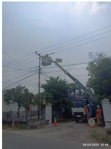
Gambar 2. 28 Perbaikan Kabel Rantas oleh Tim PDKB Sumber: (Dokumentasi Pribadi, 2024)
