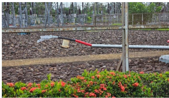
Gambar 2. 43 Inspeksi Pekerjaan Jointing Kabel Sumber: (Dokumentasi Pribadi, 2024)
