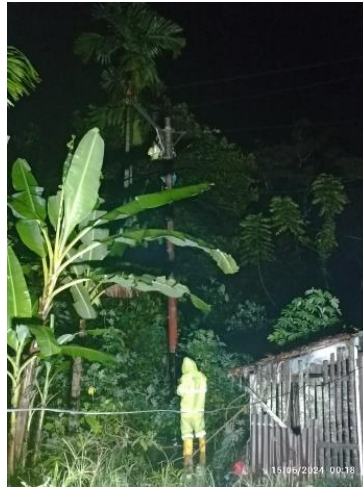
Gambar 2. 64 Penyambungan Kabel SUTM Sumber: (Dokumentasi Pribadi, 2024)
