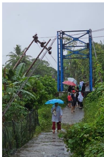
Gambar 2. 16 Inspeksi Jaringan Tegangan Menengah Sumber: (Dokumentasi Pribadi, 2024)
