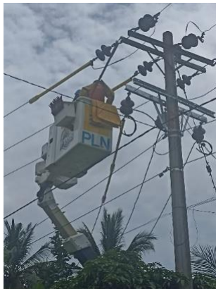
Gambar 2. 10 Pemasangan Isolator Tarik Sumber: (Dokumentasi pribadi, 2024)
