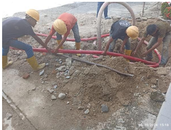
Gambar 2. 44 Inspeksi Pekerjaan Mengganti Kabel Tanah Sumber: (Dokumentasi Pribadi, 2024)
