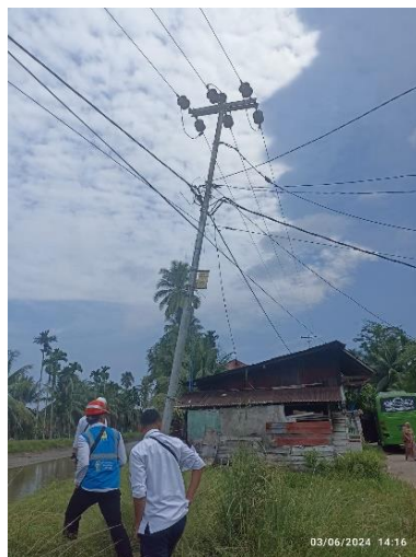
Gambar 2. 57 Inspeksi Jaringan Tegangan Menengah Sumber: (Dokumentasi Pribadi, 2024)
