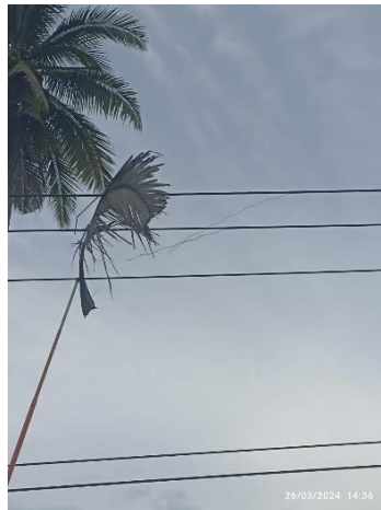
Gambar 2. 26 Inspeksi Jaringan Tegangan Menengah Sumber: (Dokumentasi Pribadi, 2024)
