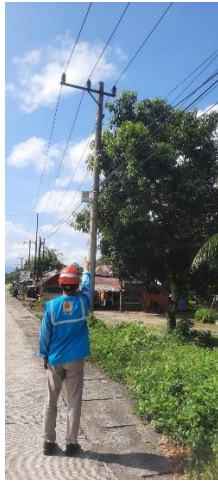
Gambar 2. 40 Pengecekan Keamanan Jaringan Listrik Sumber: (Dokumentasi Pribadi, 2024)
