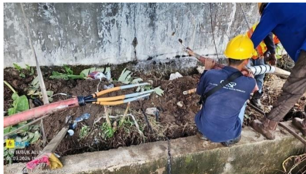
Gambar 2. 11 Pemasangan Kabel Tanah Sumber: (Dokumentasi pribadi, 2024)
