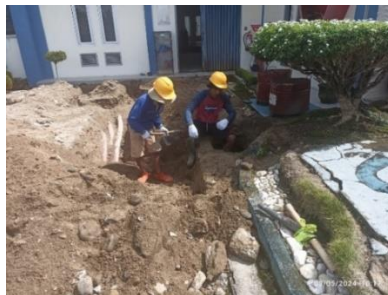
Gambar 2. 41 Inspeksi Pemasangan Kabel Tanah Sumber: (Dokumentasi Pribadi, 2024)
