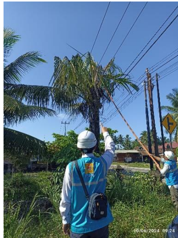
Gambar 2. 60 Kegiatan ROW ( Right of Way ) Sumber: (Dokumentasi Pribadi, 2024)
