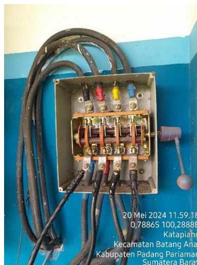
Gambar 2. 50 Pengecekan dan Siaga Genset Sumber: (Dokumentasi Pribadi, 2024)
