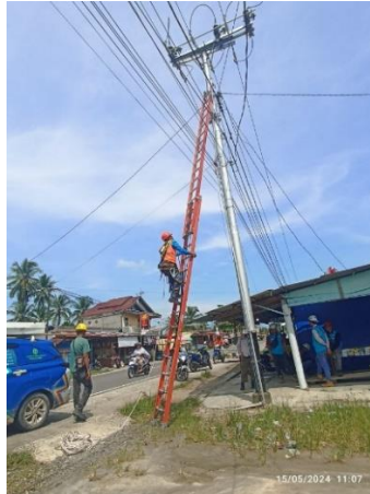
Gambar 2. 47 Perbaikan PTS ( Pole Top Switch ) Sumber: (Dokumentasi Pribadi, 2024)
