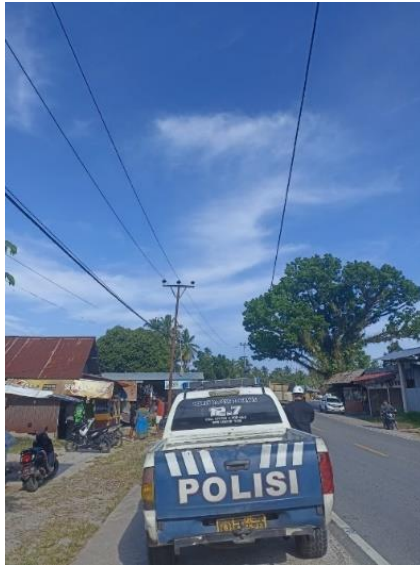
Gambar 2. 18 Inspeksi Jaringan Tegangan Menengah Sumber: (Dokumentasi Pribadi, 2024)
