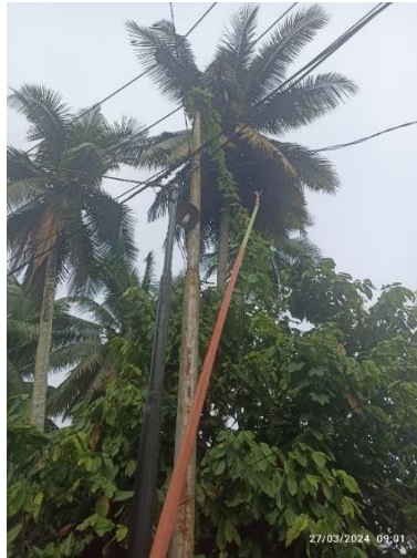
Gambar 2. 27 Kegiatan ROW ( Right of Way ) Sumber: (Dokumentasi Pribadi, 2024)
