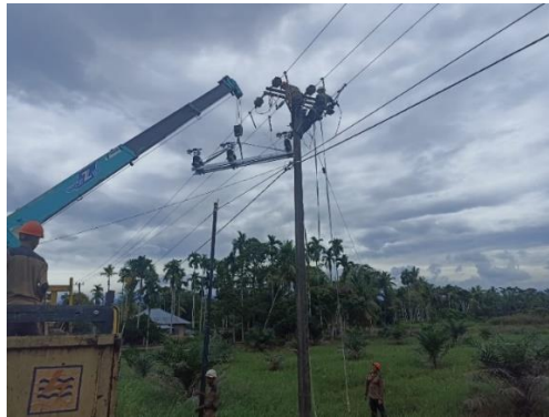
Gambar 2. 7 Pemasangan Pole Top Switch Sumber: (Dokumentasi pribadi, 2024)
