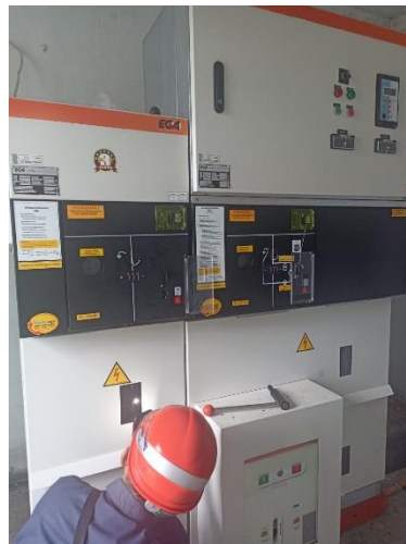
Gambar 2. 33 Pengecekan Kubikel POLTEKPEL SUMBAR Sumber: (Dokumentasi Pribadi, 2024)
