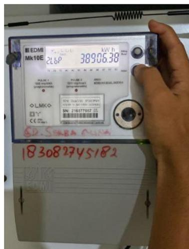
Gambar 2. 24 Proses Pemeriksaan Stand KWh Meter 3 Fasa
