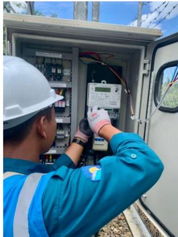
Gambar 2.19 Penggantian KWh Meter 3 Fasa
