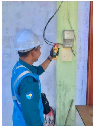
Gambar 2.18 Pengecekan Arus Pada kWh Meter 1 Fasa
