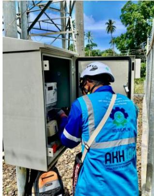
Gambar 2.9 Penggantian kWh Meter 3 Fasa
