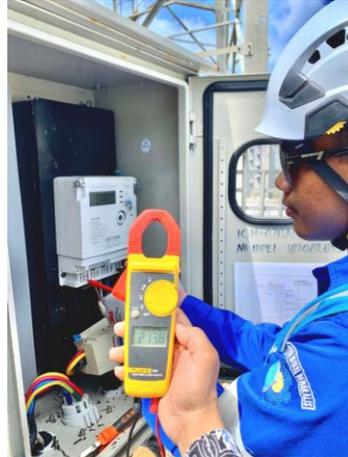
Gambar 2.6 Pemeriksaan Tegangan Pada KWh Meter 3 Fasa
