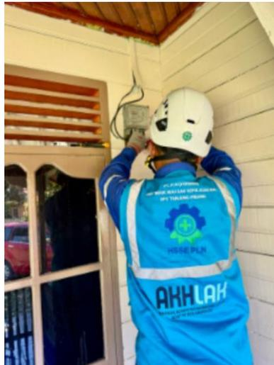
Gambar 2. 21 Penggantian KWh Meter 1 Fasa
