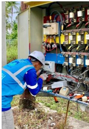
Gambar 2.3 Penggantian kWh Meter 3 Fasa
