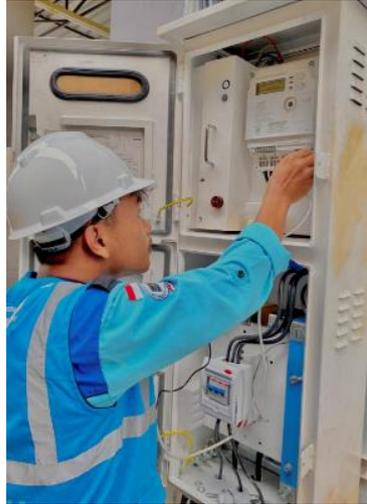
Gambar 2.2 Pemasangan Modem
