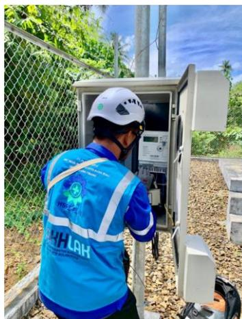
Gambar 2.7 Pengecekan KWh Meter 3 Fasa
