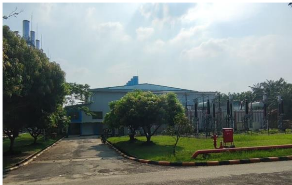
Gambar 1. 1 PT. PLN Nusantara Power ULPLTG/MG Duri Sumber: Dokumen Pribadi
