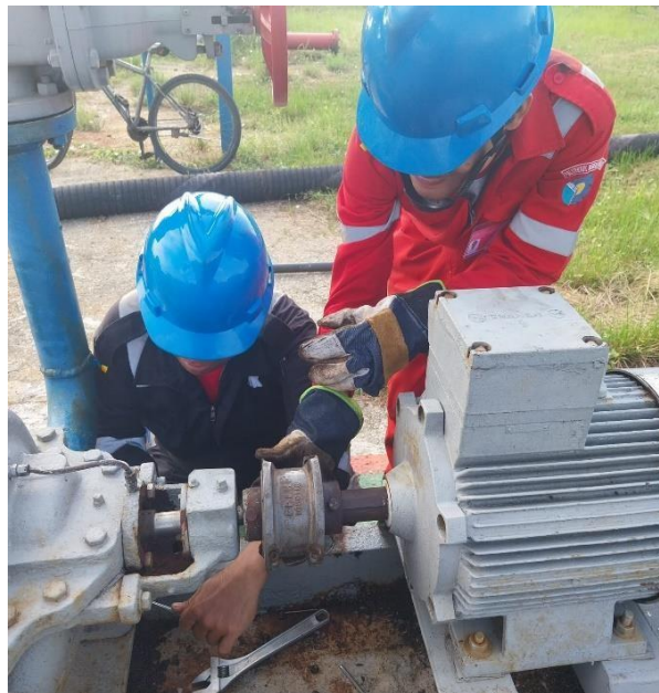
Gambar lampiran 1: pembongkaran sump pump (Sumber. PT.Pertamina RU II Sei.Pakning)
