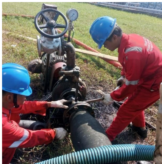
Gambar lampiran 2: pembongkaran pipa transfer pump (Sumber. PT.Pertamina RU II Sei.Pakning)
