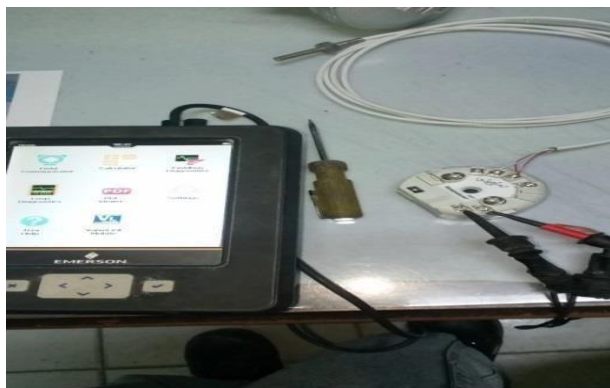
Gambar 3. 10 Koneksi dua kabel (sumber ; Dokumentasi di PT. Indah Kiat Pulp and Paper)
