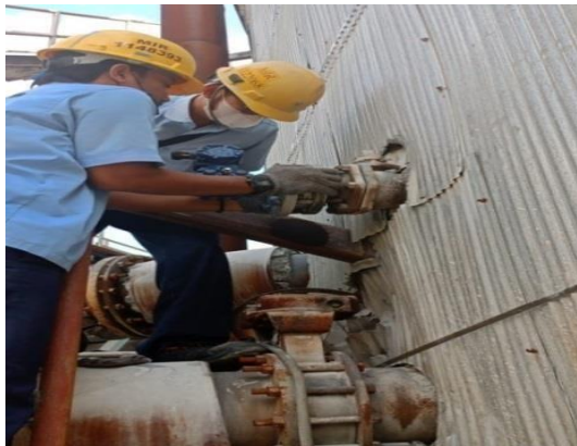
Gambar 2. 3 Bongkar Level transmitter (Sumber : dokumentasi penulis, 2024)
