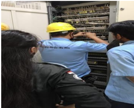
Gambar 2. 2 Pemasangan kabel multicore di rak room untuk channel (Sumber : dokumentasi penulis, 2024)
