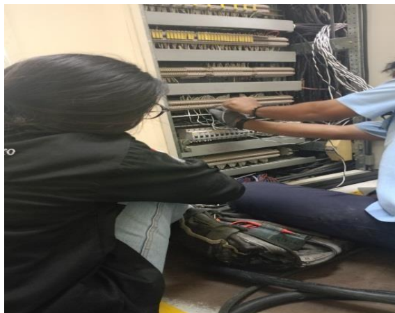
Gambar 2. 6 Pasang kabel DCS (sumber ; Dokumentasi penulis, 2024)
