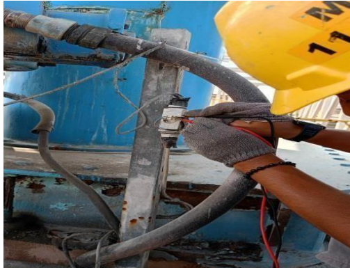
Gambar 2. 4 Ganti speed sensor untuk motor agitator spill tank (Sumber : dokumentasi penulis, 2024)
