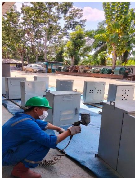
Gambar kegiatan 2. Pengecatan *body* panel
