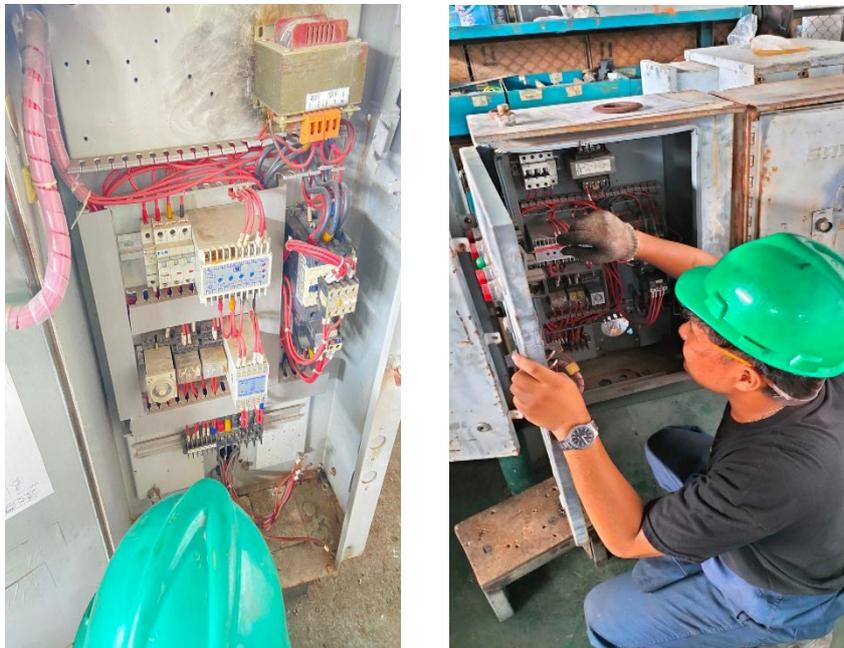
Gambar 2.6 Proses Pengetesan Panel
