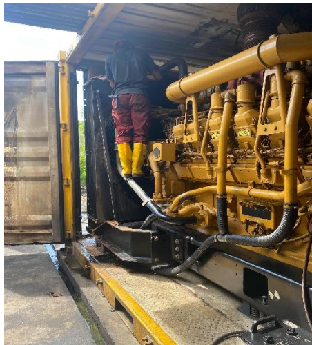
Gambar 4.3 Pembersihan sampah pada radiator
