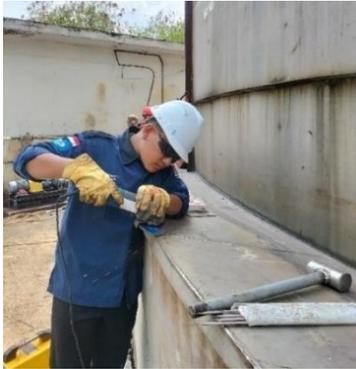
**Gambar 4. 18 pengamplasan pada permukaan**
