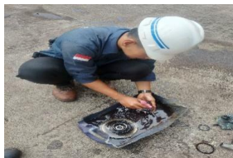
Gambar 4. 13 Pembersihan komponen pompa
