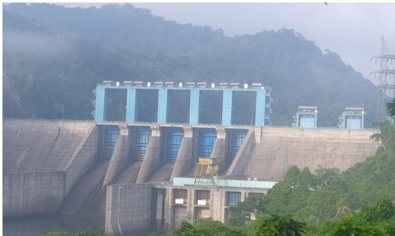
Gambar 1. 1. Unit Layanan PLTA Koto Panjang (Sumber: Unit Layanan PLTA Koto Panjang. 2024)
