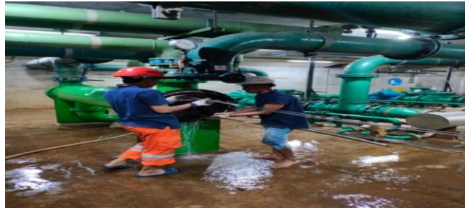
Gambar 2. 7 Maintenance pada HE ( Heat Exchanger ) unit 2 (Sumber: Unit Layanan PLTA Koto Panjang. 2024)
