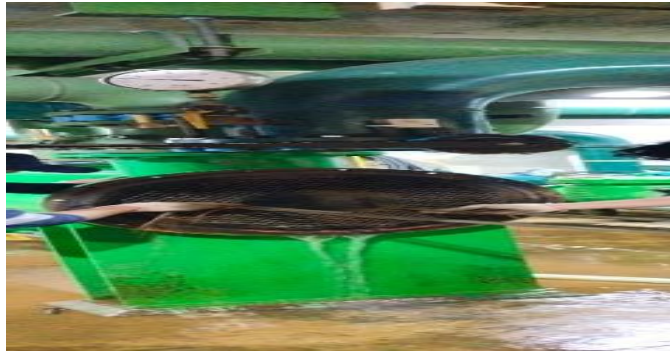
Gambar 2. 44 Maintenance HE pada unit 2 (Sumber: Unit Layanan PLTA Koto Panjang. 2024)
