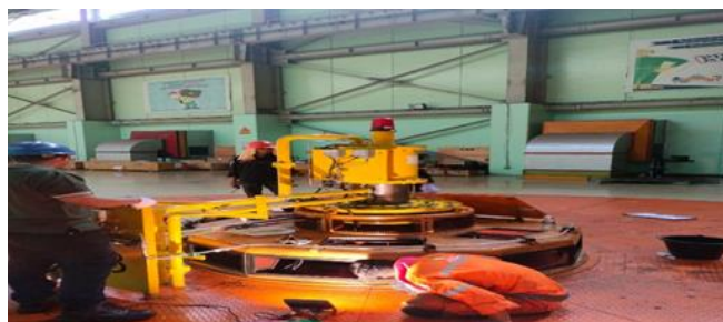
Gambar 2. 36 Maintance pada unit 3 (Sumber: Unit Layanan PLTA Koto Panjang. 2024)
