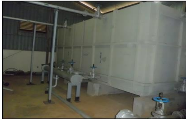
Gambar 3. 11 Raw Water Tank (Sumber: Unit Layanan PLTA Koto Panjang, 2024)
