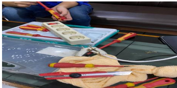
Gambar 2. 5 Pemasangan cok sambung diruangan (Sumber: Unit Layanan PLTA Koto Panjang. 2024)
