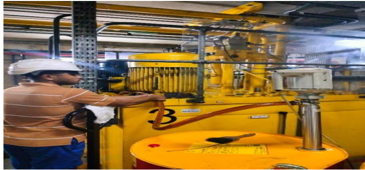
Gambar 2. 52 Mengisi oli pada pompa loader dan un loader pada unit 3 (Sumber: Unit Layanan PLTA Koto Panjang. 2024)
