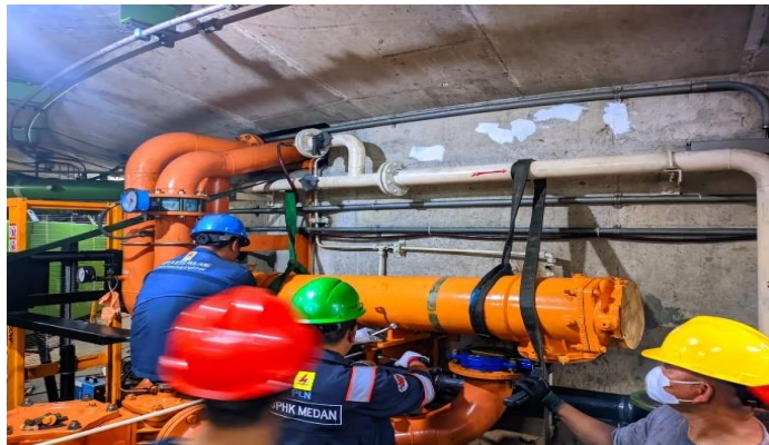
Gambar 2. 51 Pemasangan oil cooler pada unit 3 (Sumber: Unit Layanan PLTA Koto Panjang. 2024)
