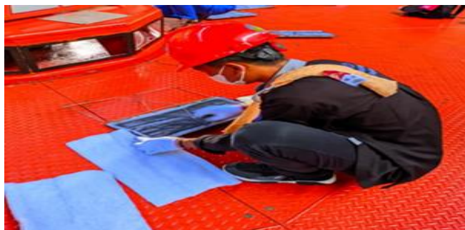
Gambar 2. 21 pemasangan filter pada slip ring (Sumber: Unit Layanan PLTA Koto Panjang. 2024)
