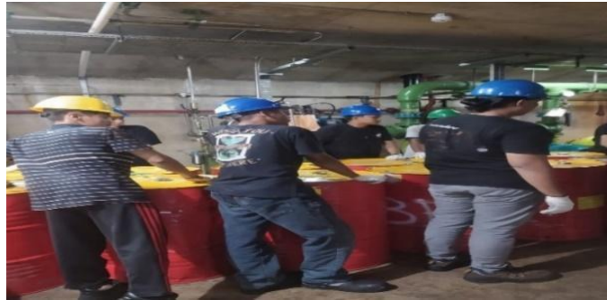
Gambar 2. 39 Pemindahan oli dari unit 2 PLTA (Sumber: Unit Layanan PLTA Koto Panjang. 2024)
