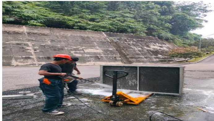
Gambar 2.50 Pembersihan air cooler (Sumber: Unit Layanan PLTA Koto Panjang. 2024)
