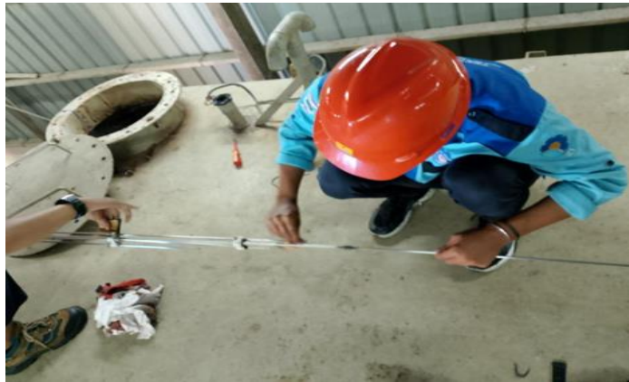
Gambar 3. 25 Pembersihan Level Switch (Sumber: Unit Layanan PLTA Koto Panjang. 2024)
