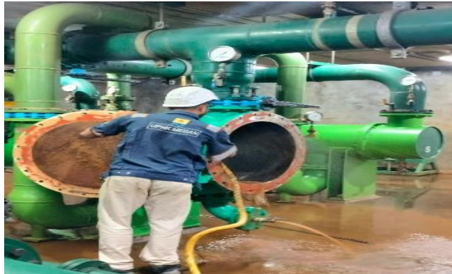
Gambar 2. 50 Maintenance HE pada unit 1 (Sumber: Unit Layanan PLTA Koto Panjang. 2024)
