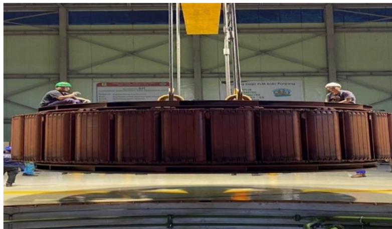
Gambar 3. 5 Rotor PLTA Koto Panjang (Sumber: Arsip Perusahaan)
