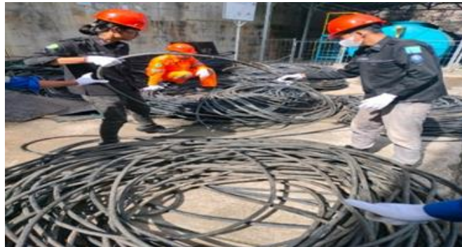
Gambar 2. 28 Penarikan kabel 3 fasa (Sumber: Unit Layanan PLTA Koto Panjang. 2024)
