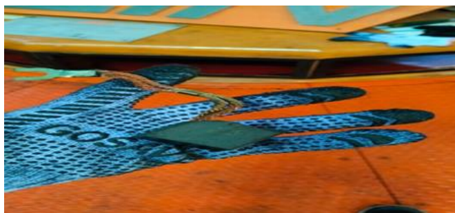
Gambar 2. 26 Pergantian carbon brush (Sumber: Unit Layanan PLTA Koto Panjang. 2024)
