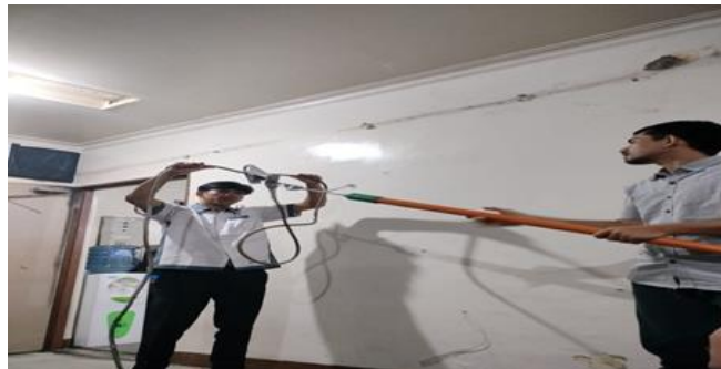
Gambar 2. 33 Belajar cara penggunaan alat untuk pemasangan kabel ground pada tiang trafo (Sumber: Unit Layanan PLTA Koto Panjang. 2024)
