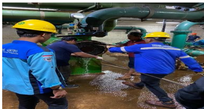
Gambar 2. 6 Maintenance pada HE ( Heat Exchanger) unit 3 (Sumber: Unit Layanan PLTA Koto Panjang. 2024)
