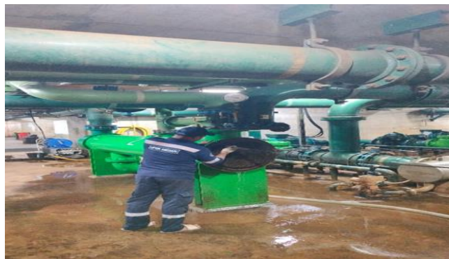
Gambar 2. 40 Maintenance HE pada unit 2 (Sumber: Unit Layanan PLTA Koto Panjang. 2024)
