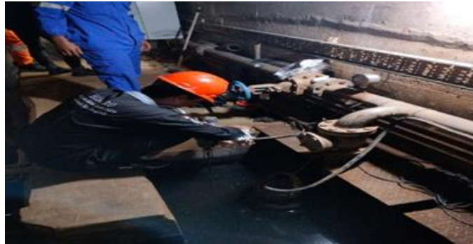
Gambar 2. 29 Pembersihn level switch pada DAM Galeri (Sumber: Unit Layanan PLTA Koto Panjang. 2024)
