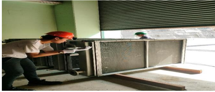
Gambar 2. 48 Membuka baut dan mur pada air cooler (Sumber: Unit Layanan PLTA Koto Panjang. 2024)
