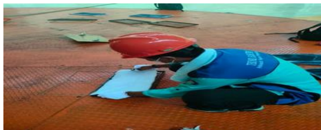
Gambar 2. 31 Pemasangan filter pada slip ring (Sumber: Unit Layanan PLTA Koto Panjang. 2024)
