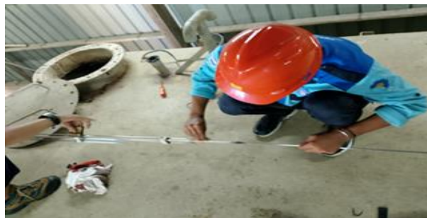
Gambar 2. 15 Pemeliharaan control level switch pada sistem Water Treatment Plant (Sumber: Unit Layanan PLTA Koto Panjang. 2024)
