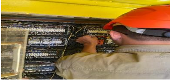
Gambar 2. 27 Perbaiki crane tail race (Sumber: Unit Layanan PLTA Koto Panjang. 2024)
