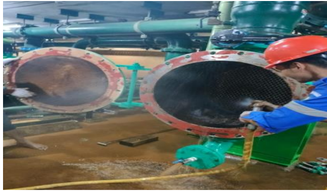
Gambar 2. 47 Maintenance HE pada unit 1 (Sumber: Unit Layanan PLTA Koto Panjang. 2024)
