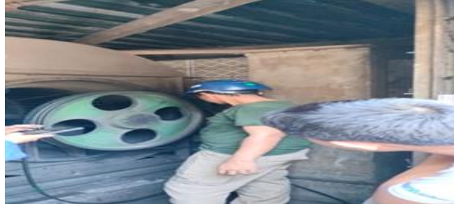
Gambar 2. 32 Mengganti belthing (Sumber: Unit Layanan PLTA Koto Panjang. 2024)
