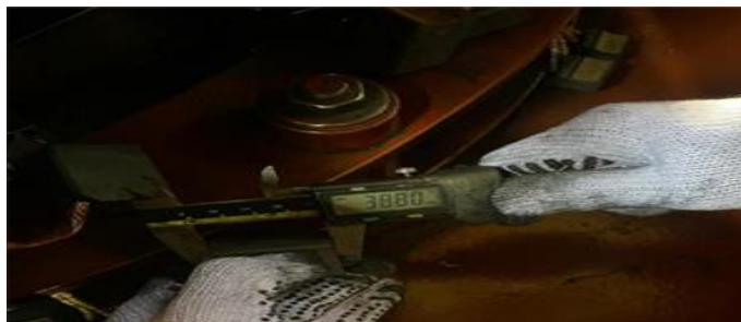
Gambar 2. 8 Pengukuran Carbon Brush pada unit 2 (Sumber: Unit Layanan PLTA Koto Panjang. 2024)
