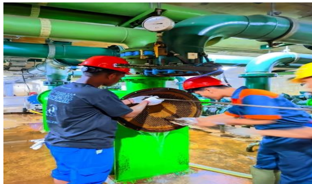
Gambar 2. 47 Maintenance HE pada unit 2 (Sumber: Unit Layanan PLTA Koto Panjang. 2024)
