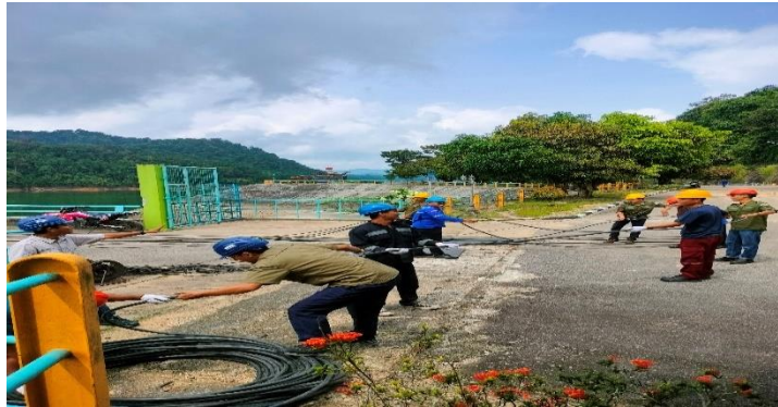
Gambar 2.59 Menggulung kabel di spillway (Sumber: Unit Layanan PLTA Koto Panjang. 2024)
