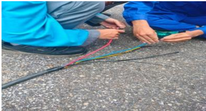
Gambar 2. 30 Pemasangan kabel atau penyambungan pada kabel 1 fasa (Sumber: Unit Layanan PLTA Koto Panjang. 2024)
