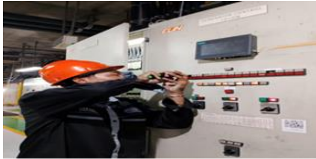
Gambar 2. 9 penggantian lampu - lampu indikator (Sumber: Unit Layanan PLTA Koto Panjang. 2024)
