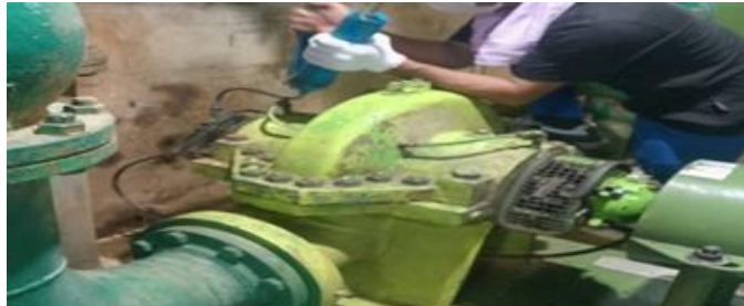
Gambar 2. 22 penambahan grease pada pompa dan motor (Sumber: Unit Layanan PLTA Koto Panjang. 2024)
