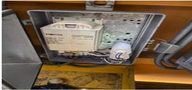
Gambar 2. 17 pengecekan dan mengganti bola lampu pada crane (Sumber: Unit Layanan PLTA Koto Panjang. 2024)
