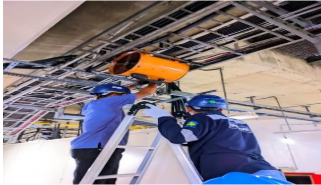
Gambar 2. 42 Membersihkan blower (Sumber: Unit Layanan PLTA Koto Panjang. 2024)
