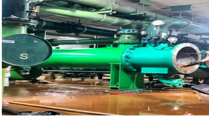
Gambar 2. 57 Maintenance HE pada unit 1 (Sumber: Unit Layanan PLTA Koto Panjang. 2024)
