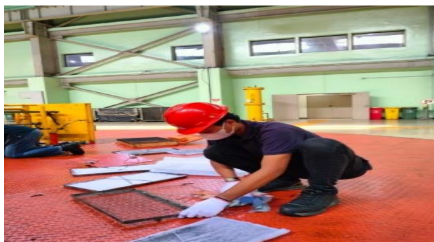
Gambar 2. 46 Pergantian filter slip ring (Sumber: Unit Layanan PLTA Koto Panjang. 2024)
