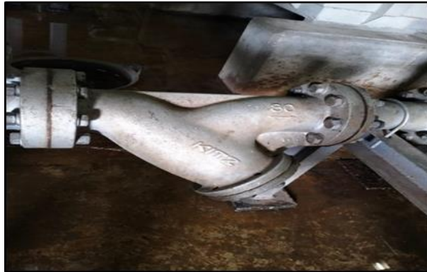
Gambar 3.15 Strainer (Sumber: Unit Layanan PLTA Koto Panjang. 2024)
