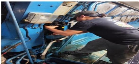
**Gambar 2. 21 Penggantian Filter insert**
