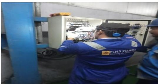
**Gambar 2. 9 penggantian kontaktor pada kontrol motor inlet vent**
