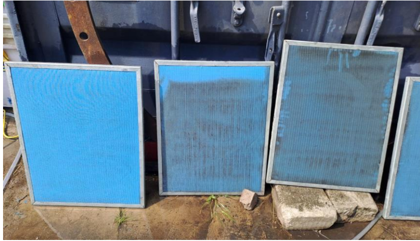
Gambar 4. 4 Pengerjaan pembersihan filter generator menggunakan air
