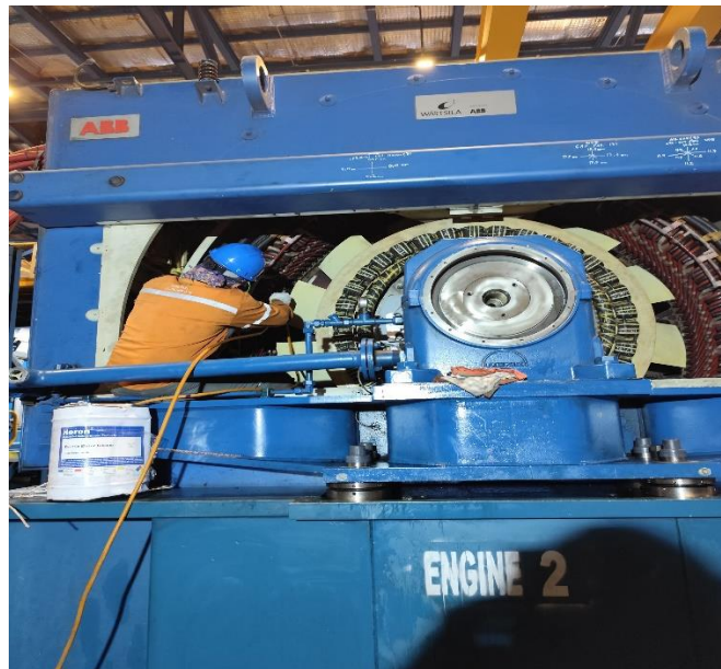
Gambar 4. 5 Pengerjaan pembersihan debu yang nempel di stator dan rotor menggunakan Chemical Elektrikal motor cleaner
