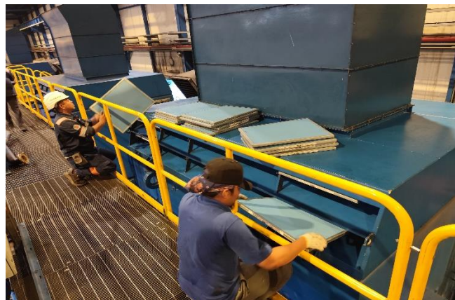
Gambar 4. 3 Pengerjaan cleaning dan inspek generator
