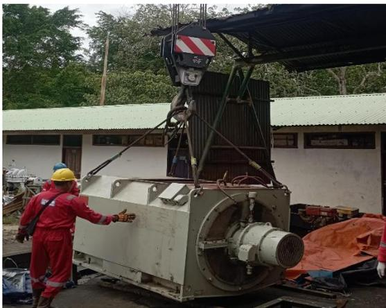
Gambar 2. 17 Membantu pemindahan generator yg sudah diprepare ke kurau plan
