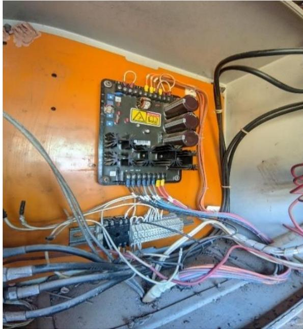
Gambar 3. 7 AVR yang telah di pasang di generator
