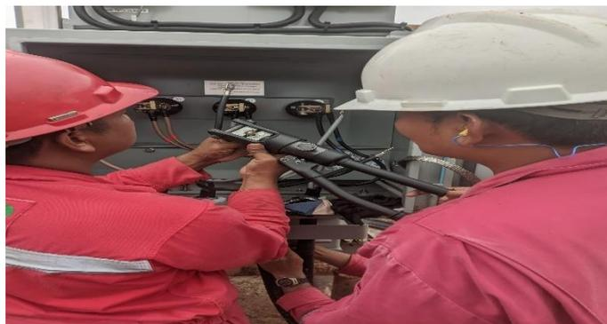
Gambar 2. 6 Termination kabel di MSTA
