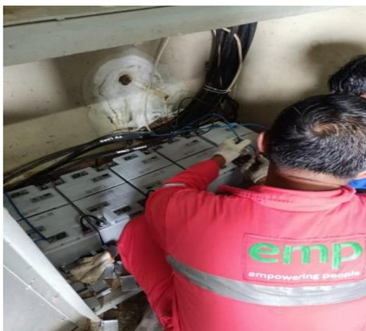
Gambar 2. 11 Memasang charger baterai 12V di AC3
