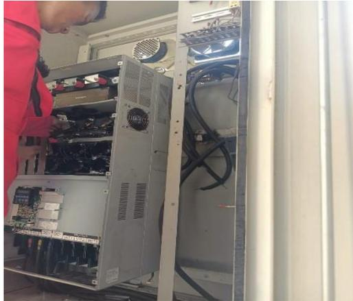
Gambar 2. 12 Memasang charger baterai 12V di AC3
