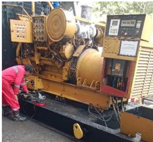
Gambar 2. 9 Intalasi connect kabel power from generator to load bank untuk capability test
