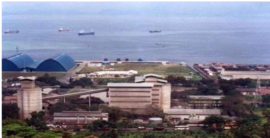
Gambar 1.8 Pabrik Panjang PT Semen Baturaja Tbk. (Bagian Personalia PT. Semen Baturaja Tbk, 2023)
