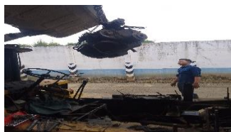
Gambar 4. 16 Proses Penurunan Mesin Sumber: Dokumen Pribadi
