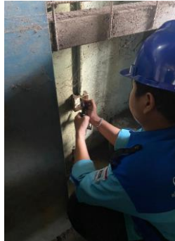
Gambar 2. 29 Perbaikan Stop Kontak Di Workshop Mechanical Sumber : (Dokumentasi, 2024)
