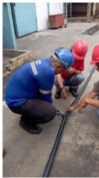
Gambar 2. 42 Pemotongan Kabel Untuk Power Source Panel Chiller
