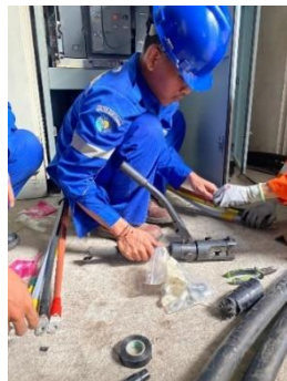
Gambar 2. 43 Memasang Skun Pada Kabel Power Source
