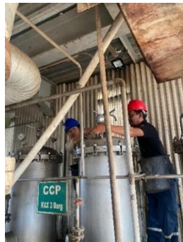
Gambar 2. 41 Pemasangan Pressure Gauge Sumber : (Dokumentasi, 2024)
