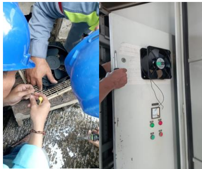
Gambar 2. 28 Proses Pemasangan Cooling Fan Pada Panel Sumber : (Dokumentasi, 2024)
