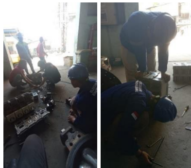
Gambar 2. 37 Proses Perbaikan ACB Sumber : (Dokumentasi, 2024)
