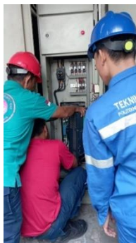
Gambar 2. 35 Pemasangan Terminal Pada Inverter Panel MCC Cooling Tower Sumber : (Dokumentasi, 2024)
