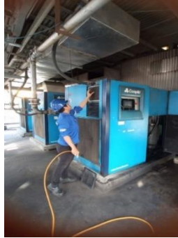
Gambar 2. 17 Membersihkan Filter Udara Pada Panel Control Air Compressor Sumber : (Dokumentasi, 2024)
