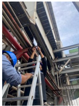
Gambar 2. 30 Mengganti Lampu Penerangan Area Refinery Sumber : (Dokumentasi, 2024)
