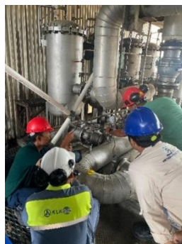
Gambar 2. 23 Kalibrasi Pressuretransmitter PFT11 Sumber : (Dokumentasi, 2024)
