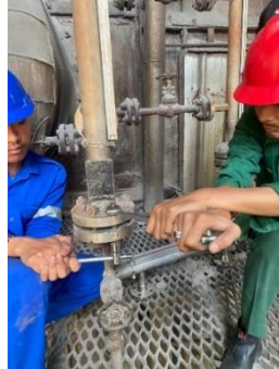
Gambar 2. 38 Melepaskan Sigh Glass Steam Dari Kedudukan Sumber : (Dokumentasi, 2024)
