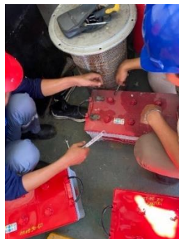
Gambar 2. 39 Mengganti Baterai Diesel Pump Pada Fire Pump House Sumber : (Dokumentasi, 2024)
