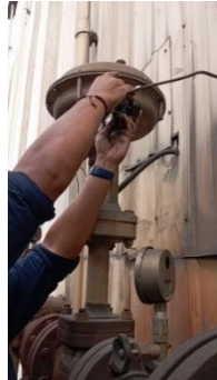
Gambar 2. 25 Penggantian Regulator Control Valve Pada Deaerator Sumber : (Dokumentasi, 2024)
