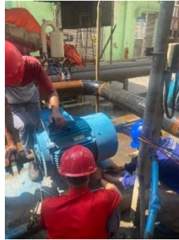
Gambar 2. 34 Melepas Electromotor 11M65 Dari Kedudukan Sumber : (Dokumentasi, 2024)
