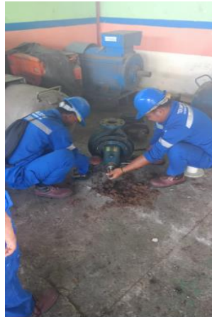
Gambar 2.1 Membongkar Pompa Sumber: PTPN IV Sei Buatan
