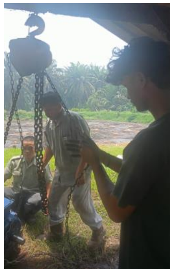
Gambar 2.60 Memasang Elmot Pompa La Sumber: PTPN IV Sei Buatn
