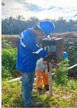
Gambar 2. 3 Memasang Flow Meter Digital Sumber: PTPN IV Sei Buatan
