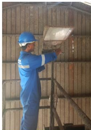
Gambar 2.7 Memasang Lampu di Pabrik Fiji Sumber: PTPN IV Sei Buatan
