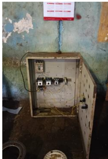
Gambar 2.14 Merangkai Star/Delta Sumber: PTPN IV Sei Buatan
