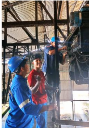
Gambar 2.40 Membongkar Elmot Sumber: PTPN IV Sei Buatan
