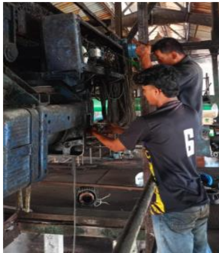
Gambar 2.41 Pengecekan Panel Sumber: PTPN IV Sei Buatan
