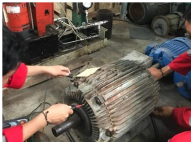
Gambar 2. 23 Cek Motor After Heater (Sumber: Dokumentasi Pribadi 2024)
