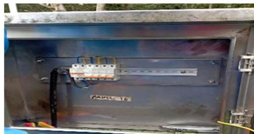
Gambar 2. 61 Pemasangan Kabel Power (Sumber: Dokumentasi Pribadi 2024)
