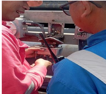
Gambar 2. 49 Pemasangan Kabel Agitator (Sumber: Dokumentasi Pribadi 2024)
