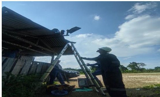
Gambar 2. 16 Install Lighting (Sumber: Dokumentasi Pribadi 2024)
