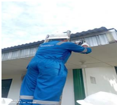
Gambar 2. 52 Pemasangan Lampu Red White (Sumber: Dokumentasi Pribadi 2024)
