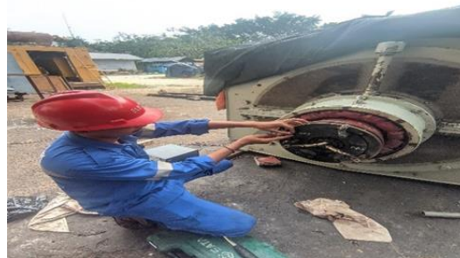
Gambar 2. 12 Pembongkaran Rotating Diet (Sumber: Dokumentasi Pribadi 2024)
