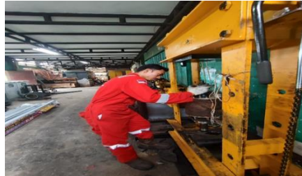
Gambar 2. 11 Mengganti Bering Motor (Sumber: Dokumentasi Pribadi 2024)
