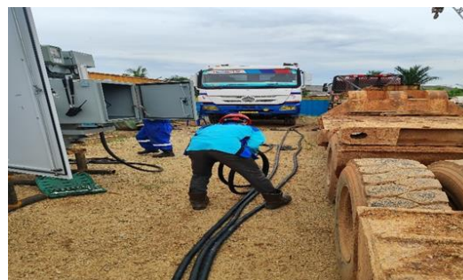
Gambar 2. 13 Gelar Kabel Di MSTA (Sumber: Dokumenatasi Pribadi 2024)
