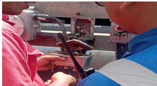
Gambar 2. 58 Servis Stop Motor (Sumber: Dokumentasi Pribadi 2024)
