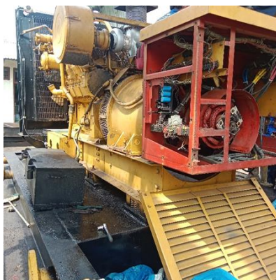
Gambar 2. 29 Servis Genset (Sumber: Dokumentasi Pribadi 2024)
