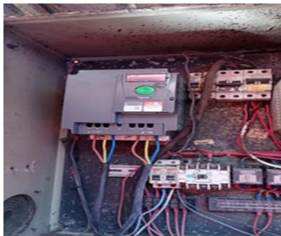
Gambar 2. 47 Pemasangan Inverter (Sumber: Dokumentasi Pribadi 2024)
