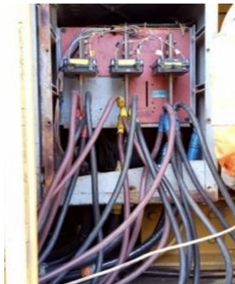
Gambar 2. 69 Tes kemampuan genset menggunakan load bank (Sumber : Dokumentasi pribadi 2024)
