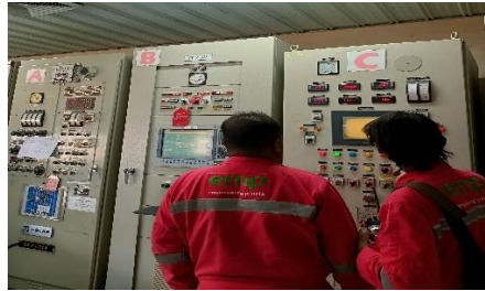
Gambar 2. 5 Synchron Turbin (sumber: dokumentasi pribadi 2024)
