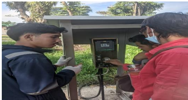
Gambar 2. 8 Pemasangan Inverter (Sumber: Dokumentasi Pribadi 2024)
