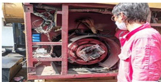
Gambar 2. 59 Servis Genset (Sumber: Dokumentasi Pribadi 2024)
