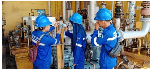
Gambar 2. 2 Pemasangan Tombol Power GT (Sumber: Dokumentasi Pribadi 2024)
