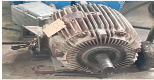
Gambar 2. 57 Cek Kondisi Motor (Sumber: Dokumentasi Pribadi 2024)
