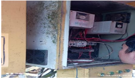
Gambar 2. 46 Survey Pemasangan Inverter (Sumber: Dokumentasi Pribadi 2024)
