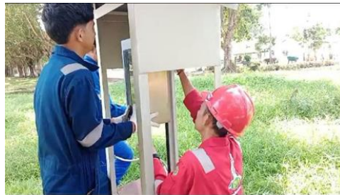
Gambar 2. 41 Pemasangan Inverter (Sumber: Dokumentasi Pribadi 2024)
