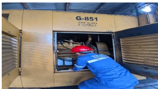
Gambar 2. 6 Prepare Engine Caterpillar (Sumber: Dokumentasi Pribadi 2024)
