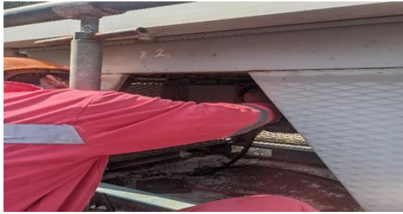
Gambar 2. 18 Megger Pada Motor Cooler (Sumber: Dokumentasi Pribadi 2024)
