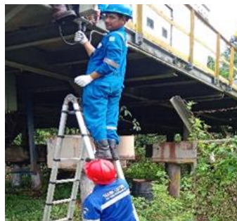
Gambar 2. 44 Mengganti Lampu Di AC22 (Sumber: Dokumentasi Pribadi 2024)
