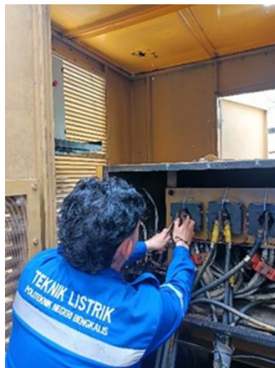
Gambar 2. 21 Connect Kabel Power Untuk Capability Test (Sumber: Dokumentasi Pribadi 2024)
