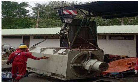
Gambar 2. 63 Pemindahan Generator (Sumber: Dokumentasi Pribadi 2024)
