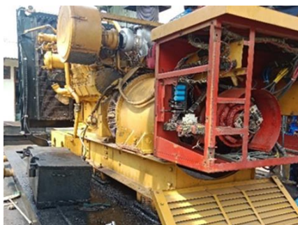
Gambar 2. 24 Mengetes Tahanan Isolasi Generator (Sumber: Dokumentasi Pribadi 2024)
