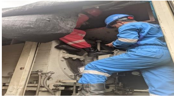
Gambar 2. 9 Pemasangan Kabel Output Pada Generator Turbin (Sumber: Dokumentasi Pribadi 2024)
