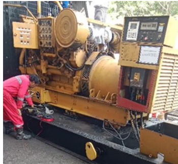
Gambar 2. 22 Setting Speed Control (Sumber: Dokumentasi Pribadi 2024)
