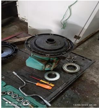
Gambar 2. 51 Mengganti Bearing Motor (Sumber: Dokumentasi Pribadi 2024)
