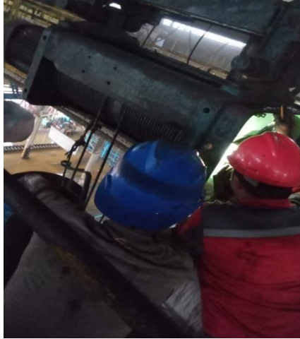
Gambar 2.7 Mengganti Seling Hoisting Crane no. 2 (sumber : dokumentasi penulis 2024)
