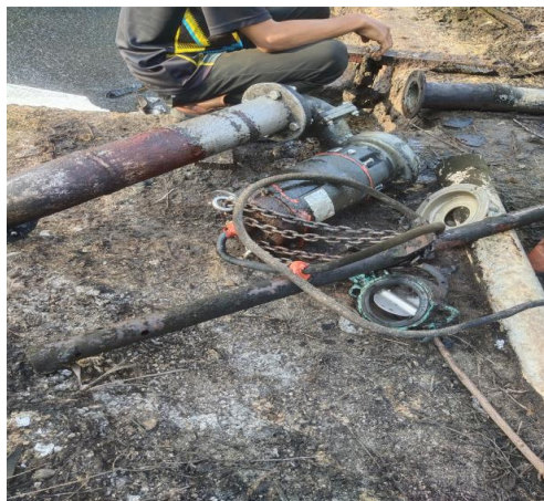
Gambar 2.8 Pengecekan Pompa Sedimentasi (sumber : dokumentasi penulis 2024)
