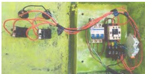
Gambar 3.3 : Bentuk fisik rangkaian DOL (Sumber : dokumentasi penulis 2024)
