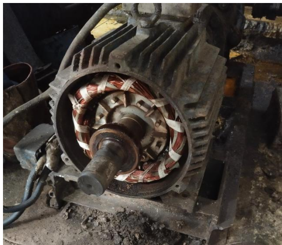
Gambar 3.9 : Persiapan Pemasangan Bearing (Sumber : Dokumentasi Penulis 2024)
