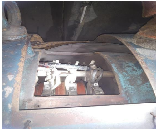
Gambar 2.3 Pengecekan motoran IDF (sumber : dokumentasi penulis 2024)
