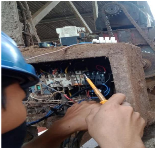
Gambar 2.5 Pembuatan Rangkaian Conveyor Cangkang (sumber : dokumentasi penulis 2024)
