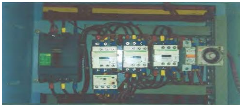
Gambar 3.5 : Rangkaian daya dan rangkaian kontrol pengasutan star-delta (Sumber : Dokumentasi penulis 2024)
