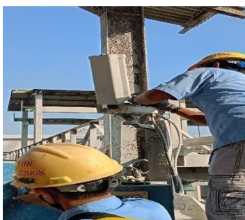
2.9. Ganti Isolator Balun
