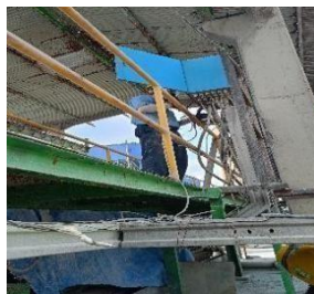
2.22. Tarik Kabel Panel Ke Dcs
