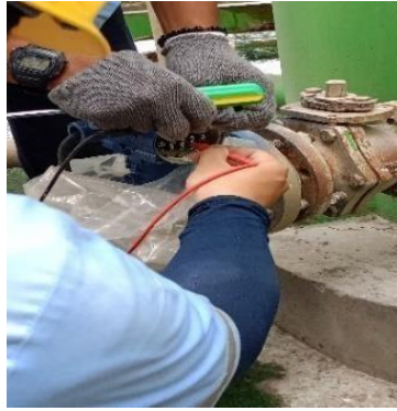
2.14. Level Transmitter Tangki Air (Sumber:PT.Indah Kiat Pulp & Paper)
