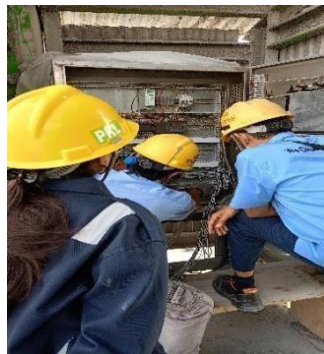
2.8. Menyambung Kabel Dcs Lapangan
