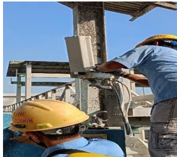
2.12. Ganti Isolator Balun
