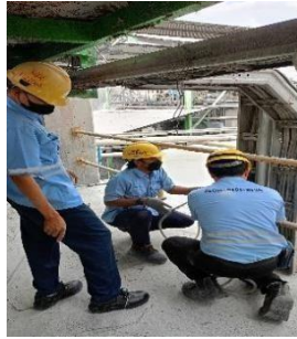
2.18 .Tarik Kabel Multi Core Press
