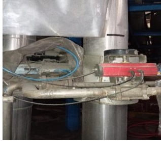
Gambar 2. 2 Gambar Mengganti tubing yang ada di Control Valve (Sumber : Dokumentasi PT. Indah Kiat Pulp & Paper Perawang 2024.).
