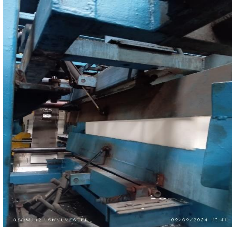
Gambar 3. 22 Cylinder Pneumatic yang digunakan mendorong bale pulp tersebut (Sumber : Dokumentasi PT. Indah Kiat Pulp & Paper, perawang. 2024.).
