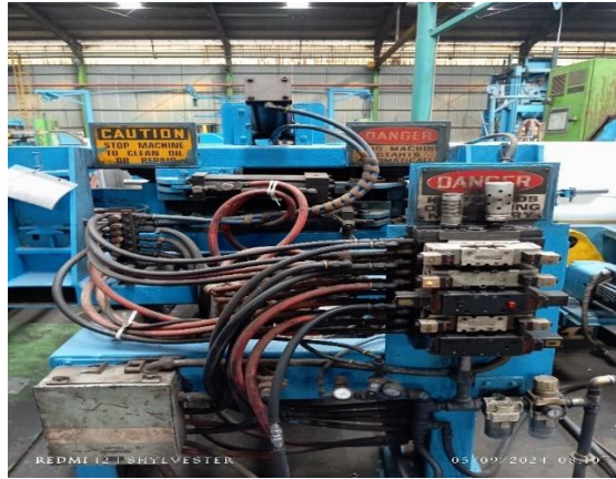
Gambar 2. 19 Gambar memasang shield pada hose yang ada di SV Area Baling lane (Sumber : Dokumentasi PT. Indah Kiat Pulp & Paper Perawang 2024.).
