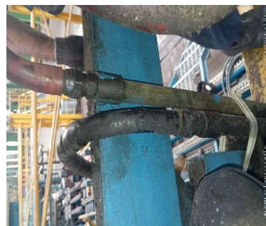
Gambar 2. 15 Gambar Ganti Hose pada SV dan Cylinder yang ada di Layboy (Sumber : Dokumentasi PT. Indah Kiat Pulp & Paper Perawang 2024.).
