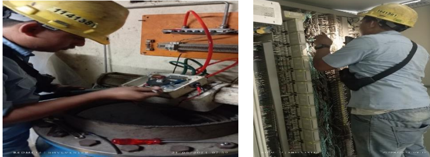
Gambar 2. 21 Gambar pengecekan dan pengkalibrasian potisioner control valve (Sumber : Dokumentasi PT. Indah Kiat Pulp & Paper Perawang 2024.).
