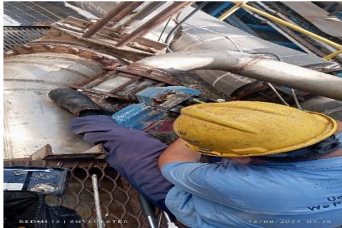
Gambar 2. 17 Gambar Memasang kabel Pada Potisioner Control Valve
