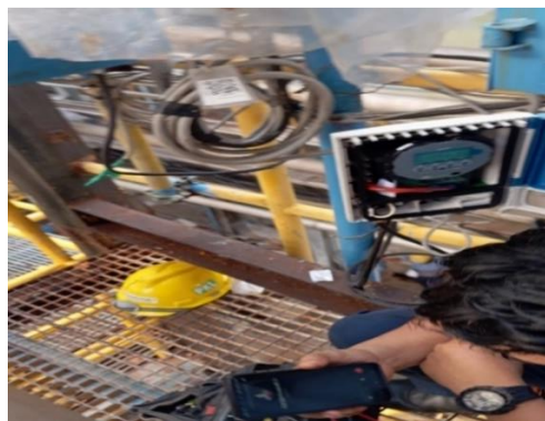
Gambar 2. 8 Gambar Mengecek tegangan yang ada DI flow Meter transmitter (Sumber : Dokumentasi PT. Indah Kiat Pulp & Paper Perawang 2024.).
