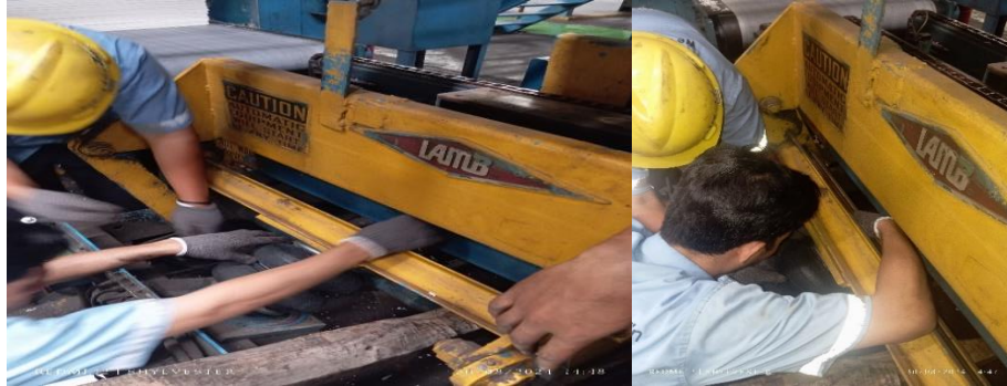
Gambar 2. 25 Gambar Ganti Airbag aligner Duowrap PD9
