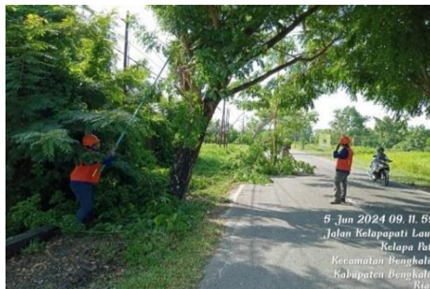
Gambar 2. 2 Pekerjaan Pemangkasan (Sumber : dokumentasi 2024)
