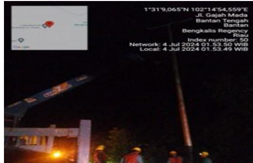
Gambar 2. 16 Pekerjaan tiang tumbang (Sumber : dokumentasi 2024)
