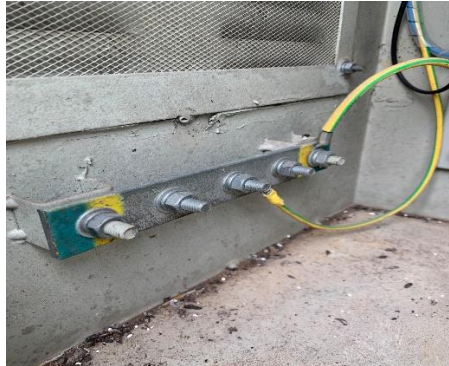
Gambar 3. 7 Sistem Pentanahan (Grounding) (Sumber : dokumentasi 2024)
