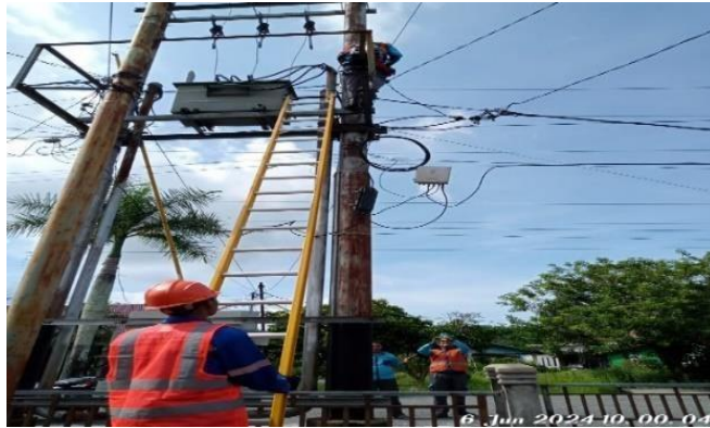
Gambar 2. 3 Pekerjaan perbaikan kabel SR ( Saluran Rendah) (Sumber : dokumentasi 2024)
