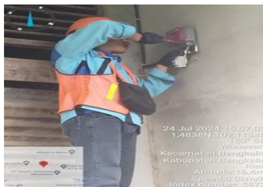
Gambar 2. 25 Pemasangan KWH Meter sementara (Sumber : dokumentasi 2024)
