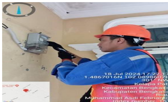
Gambar 2. 24 Penggantian MCB (Sumber : dokumentasi 2024)
