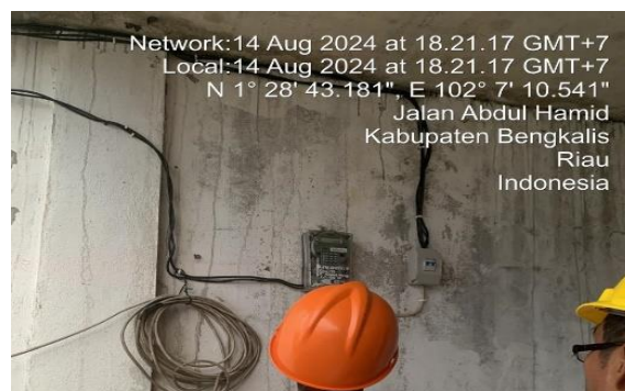
Gambar 2. 40 Gangguan pada KHW pelanggan (Sumber : dokumentasi 2024)
