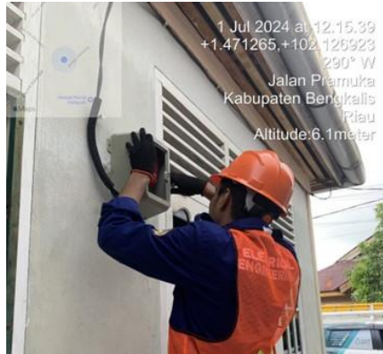
Gambar 2. 14 Pemasangan KWH Meter sementara (Sumber : dokumentasi 2024)
