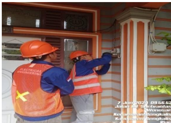
Gambar 2. 4 Pekerjaan penggantian MCB (Sumber : dokumentasi 2024)
