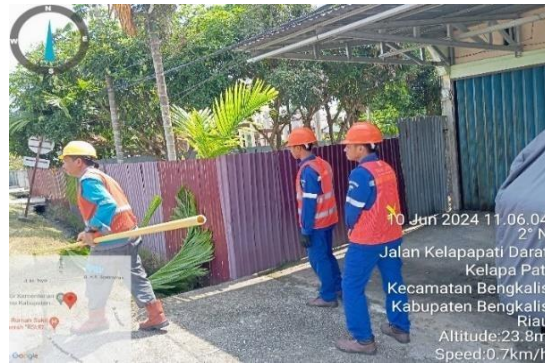
Gambar 2. 5 Pekerjaan Pemangkasan (Sumber : dokumentasi 2024)
