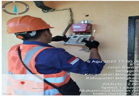
Gambar 2. 34 Pemasangan KWH Meter sementara/Dummy (Sumber : dokumentasi 2024)
