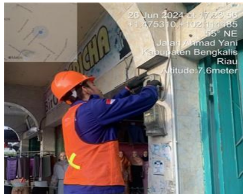
Gambar 2. 11 Pergantian MCB (Sumber : dokumentasi 2024)
