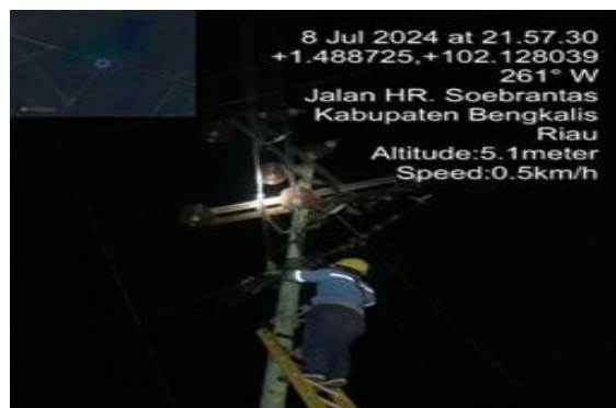
Gambar 2. 19 Perbaikan SR (Saluran Rendah) (Sumber : dokumentasi 2024)
