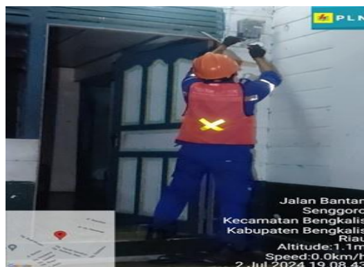
Gambar 2. 15 Penggantian MCB (Sumber : dokumentasi 2024)
