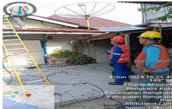
Gambar 2. 1 Pekerjaan perbaikan kabel SR (Sumber : dokumentasi 2024)
