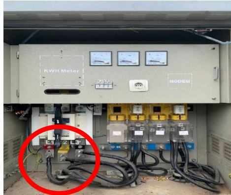
Gambar 3. 3 Saklar Utama (Sumber : dokumentasi 2024)
