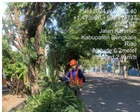
Gambar 2. 18 Pekerjaan pemangkasan (Sumber : dokumentasi 2024)
