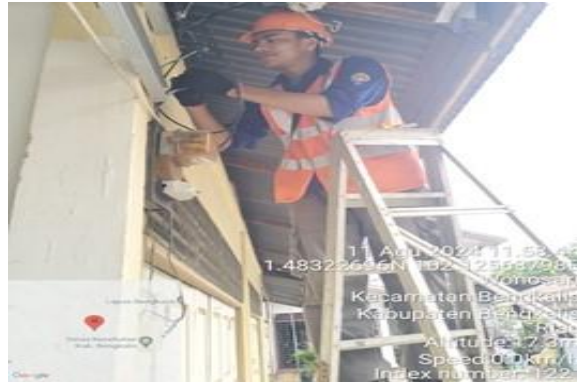
Gambar 2. 37 Pekerjaan Lost kontak
