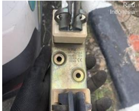
Gambar 2. 46 Penggantian NH fuse Holder (Sumber : dokumentasi 2024)
