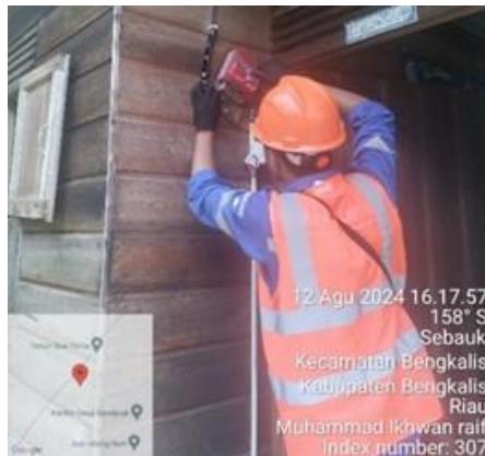
Gambar 2. 38 Pemasangan KWH Meter sementara
