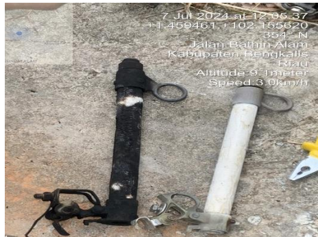
Gambar 2. 20 Pekerjaan pengantian fuse link (Sumber : dokumentasi 2024)
