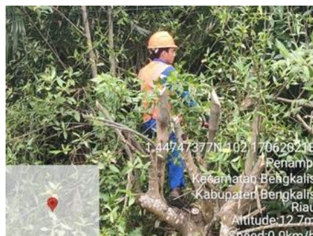
Gambar 2. 45 Pekerjaan Pemangkasan (Sumber : dokumentasi 2024)
