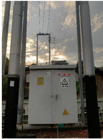
Gambar 3. 2 Kerangka PHB TR (Sumber : dokumentasi 2024)
