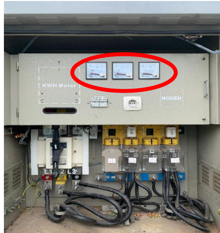
Gambar 3. 6 Indikator Arus (I) dan Tegangan (V) (Sumber : dokumentasi 2024)
