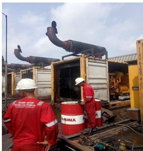
Gambar 4.3 . Memasukan oli kotor ke drum
