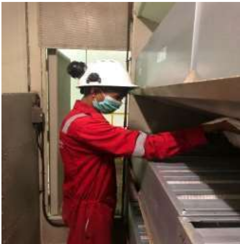
Cleaning Pada Bagian Dalam Turbin
