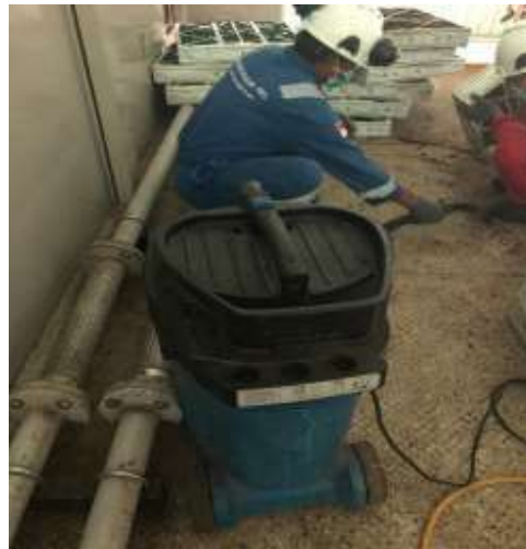
Cleaning Pada Luar Turbin
