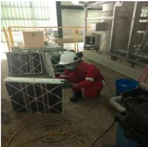
Pembersihan Saringan Turbin
