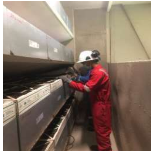
Cleaning Saringan Pada Turbin
