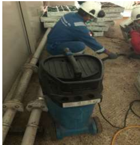
Cleaning Pada Luar Turbin
