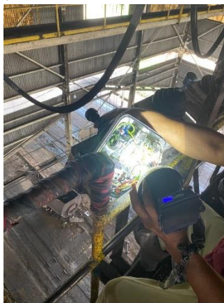
Gambar 2. 6 Kontraktor Hoisting Crane
