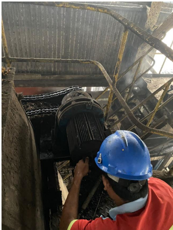
Ganti Bearing di motoran transfer
