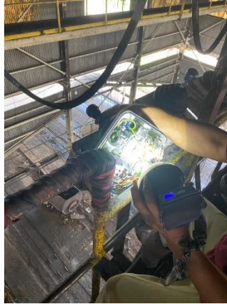
Gambar 2. 3 Mengganti Seling Hoisting Crane
