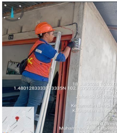
Gambar 2.25 Pergantian KWH Meter sementara/ Dummy (Sumber : dokumentasi 2024)
