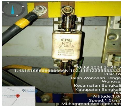
Gambar 2.33 Pergantian NH fuse (Sumber : dokumentasi 2024)
