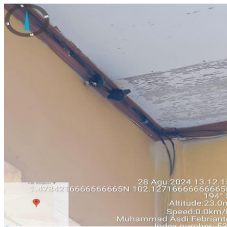
Gambar 2.51 Pekerjaan Lost kontak (Sumber : dokumentasi 2024)
