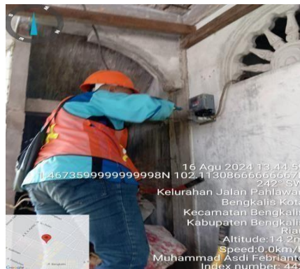
Gambar 2.43 Pemasangan KWH Meter sementara/ Dummy (Sumber : dokumentasi 2024)
