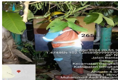
Gambar 2.36 Pengukuran beban (Sumber : dokumentasi 2024)
