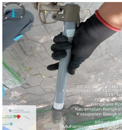
Gambar 2.28 Pergantian Fuse link pada FCO (Sumber : dokumentasi 2024)
