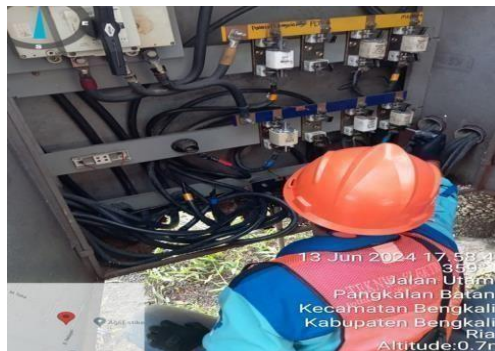
Gambar 2.8 pengukuran beban (Sumber : dokumentasi 2024)
