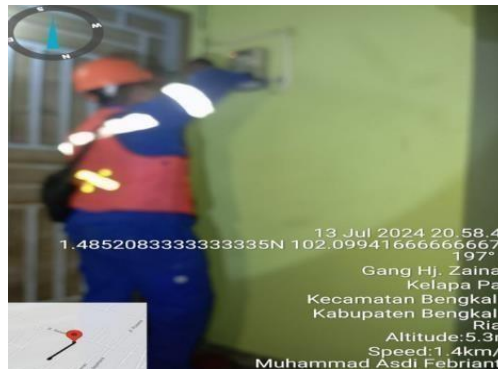
Gambar 2.23 Pergantian KWH Meter sementara/ Dummy (Sumber : dokumentasi 2024)
