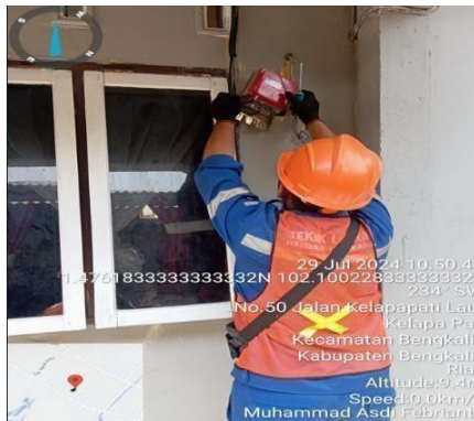
Gambar 2.32 Pergantian KWH Meter sementara/ Dummy (Sumber : dokumentasi 2024)
