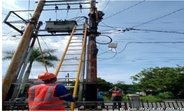
Gambar 2.3 pekerjaan perbaikan kabel SR (Sumber : dokumentasi 2024)
