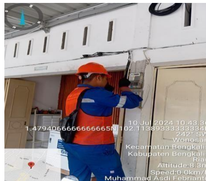
Gambar 2.20 Pergantian KWH Meter sementara/ Dummy (Sumber : dokumentasi 2024)
