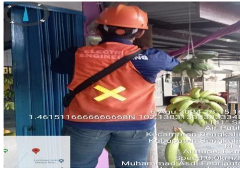
Gambar 2.37 Pemasangan KWH Meter sementara/Dummy (Sumber : dokumentasi 2024)
