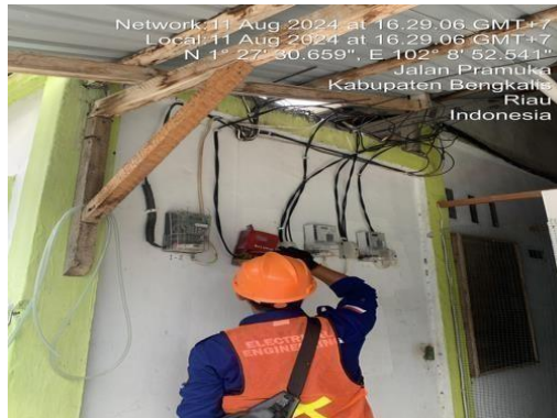
Gambar 2.40 Pemasangan KWH Meter sementara/ Dummy (Sumber : dokumentasi 2024)
