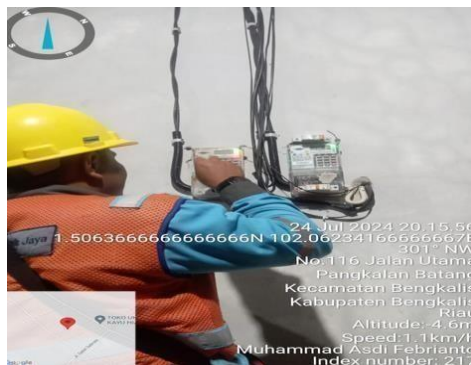
Gambar 2.29 Pergantian KWH Meter sementara/ Dummy (Sumber : dokumentasi 2024)
