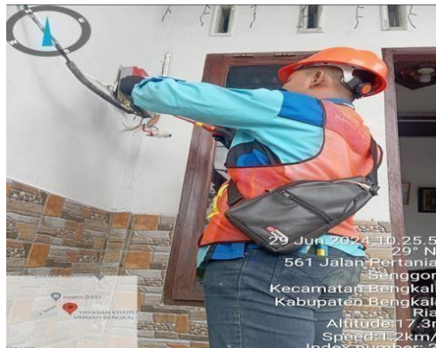
Gambar 2.14 pergantian KWH meter sementara (Sumber : dokumentasi 2024)
