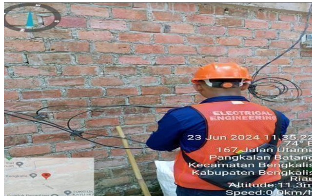
Gambar 2.11 Penyambungan kabel SR (Sumber : dokumentasi 2024)
