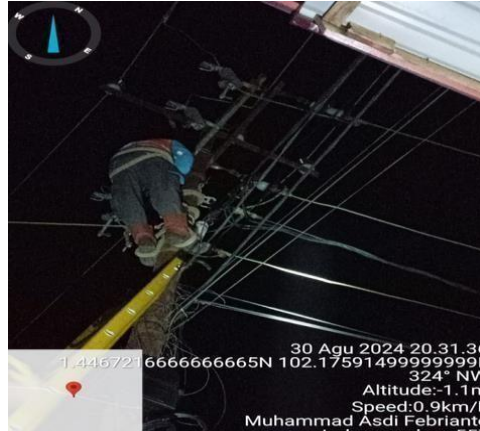
Gambar 2.53 Penyambungan kabel JTM (Sumber : dokumentasi 2024)
