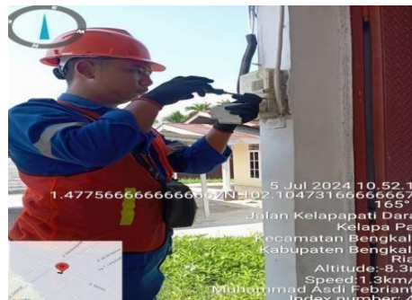
Gambar 2.17 Pergantian MCB (Sumber : dokumentasi 2024)
