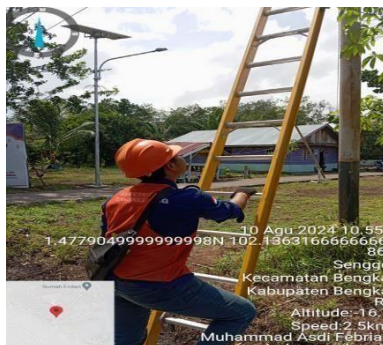
Gambar 2.39 Pekerjaan lost kontak (Sumber : dokumentasi 2024)
