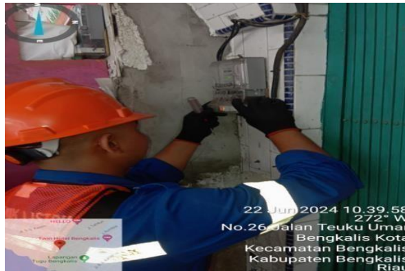
Gambar 2.10 Pergantian MCB (Sumber : dokumentasi 2024)
