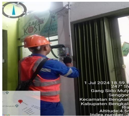
Gambar 2.15 Pergantian MCB (Sumber : dokumentasi 2024)
