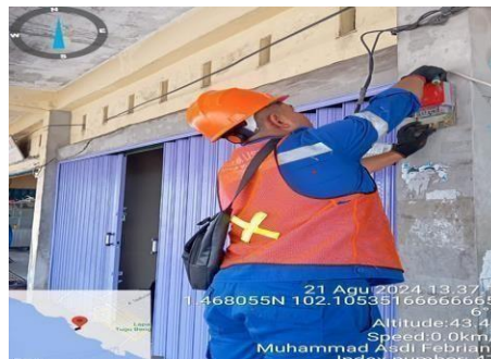
Gambar 2.46 Pemasangan KWH Meter sementara/ Dummy (Sumber : dokumentasi 2024)
