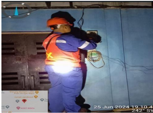
Gambar 2.12 Pergantian MCB (Sumber : dokumentasi 2024)
