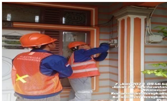
Gambar 2.4 Pekerjaan pergantian MCB (Sumber : dokumentasi 2024)
