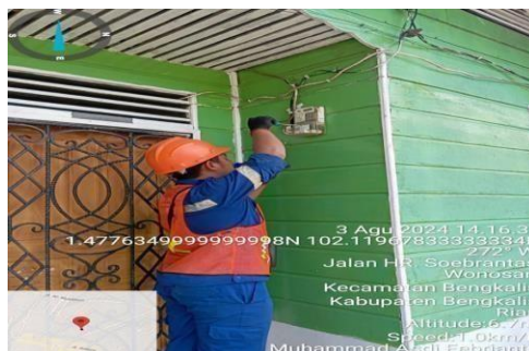
Gambar 2.34 Pemasangan KWH Meter sementara/ Dummy (Sumber : dokumentasi 2024)
