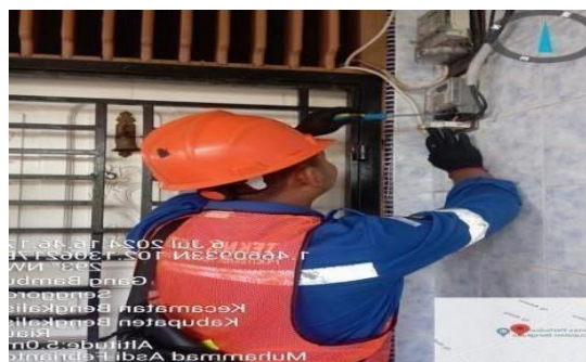
Gambar 2.18 pergantian KWH meter sementara (Sumber : dokumentasi 2024)
