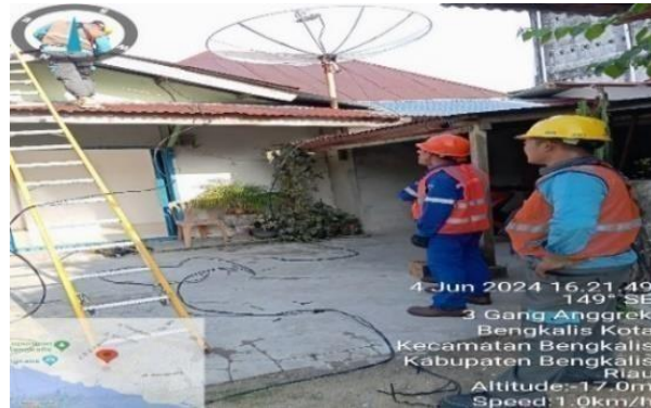
Gambar 2.1 Pekerjaan perbaikan kabel SR (Sumber : dokumentasi 2024)
