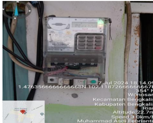
Gambar 2.19 Pergantian MCB (Sumber : dokumentasi 2024)
