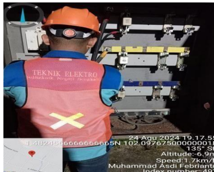
Gambar 2.49 Pengukuran Beban (Sumber : dokumentasi 2024)
