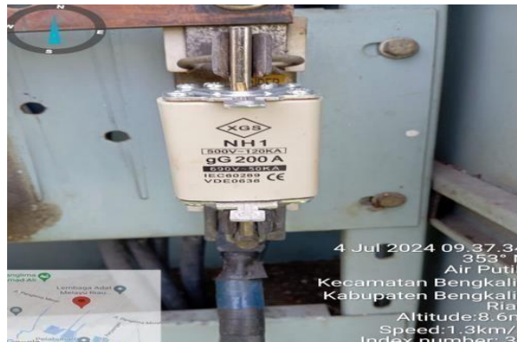
Gambar 2.16 Pergantian NH fuse (Sumber : dokumentasi 2024)
