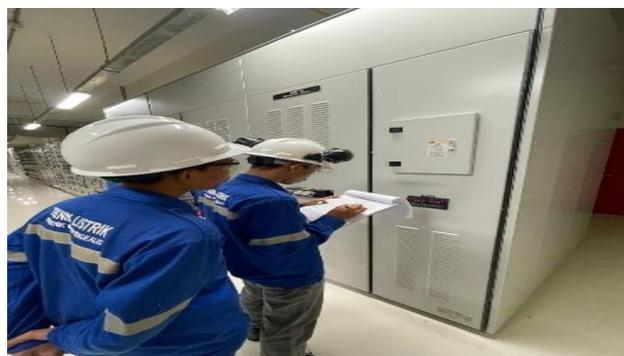
**Gambar 2. 16 Pengecekan Temperatur pada Transformator**
