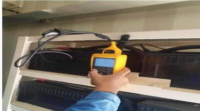
**Gambar 2. 5 Pengukuran arus, tegangan dan Resistansi**
