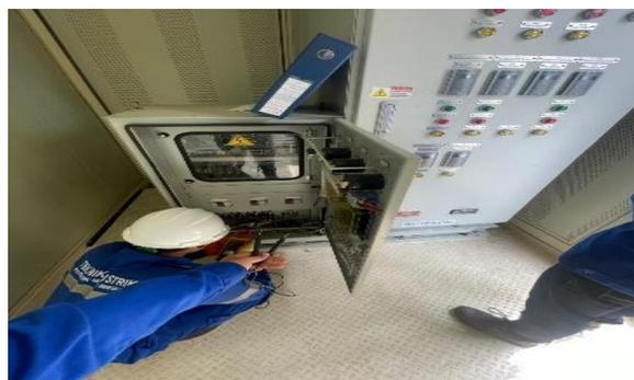
**Gambar 2. 20 Pengukuran baterai di BSDG**
