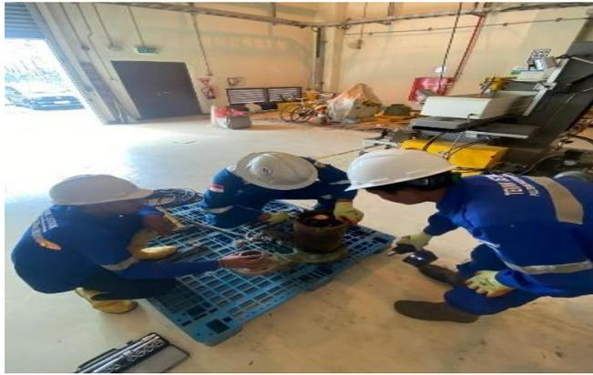
**Gambar 2. 21 Pemasangan Grounding pada motor pompa Air**
