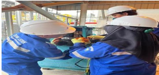
**Gambar 2. 10 Memperbaiki Motor dibagian WTP**
