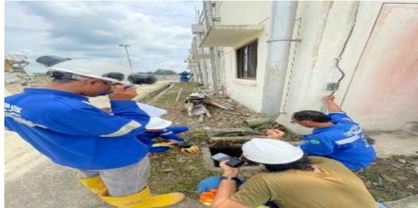
**Gambar 2. 17 Pengukuran Grounding dibagian RWI**
