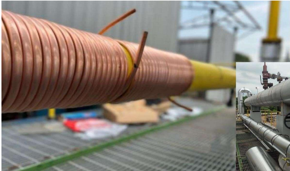
Gambar 3.2 pipa kuningan di lilitkan pada pipa minyak
