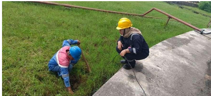
Gambar 2.3 pemasangan grounding
