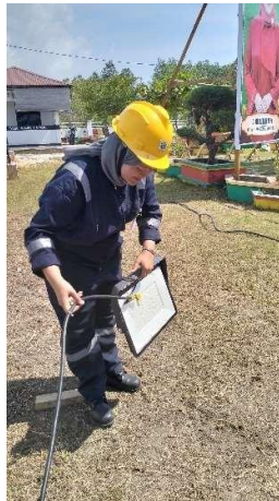
Gambar 2.4 pemasangan lampu di kantor camat Bukit Batu (Sumber: Dokumentasi di kantor camat Bukit Batu 2024)
